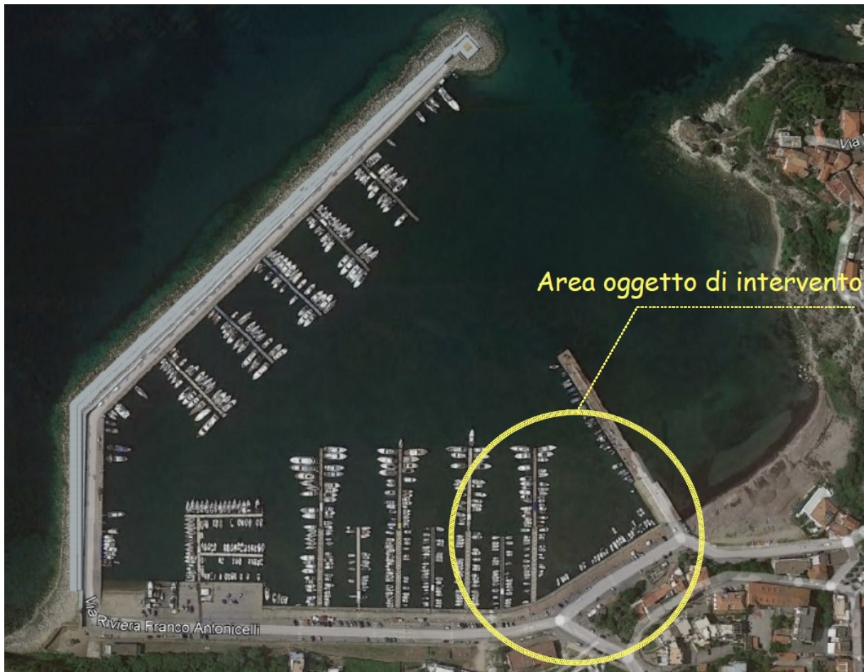
Figura 2. Vista aerea del Porto di Agropoli (Fonte: Google maps).
