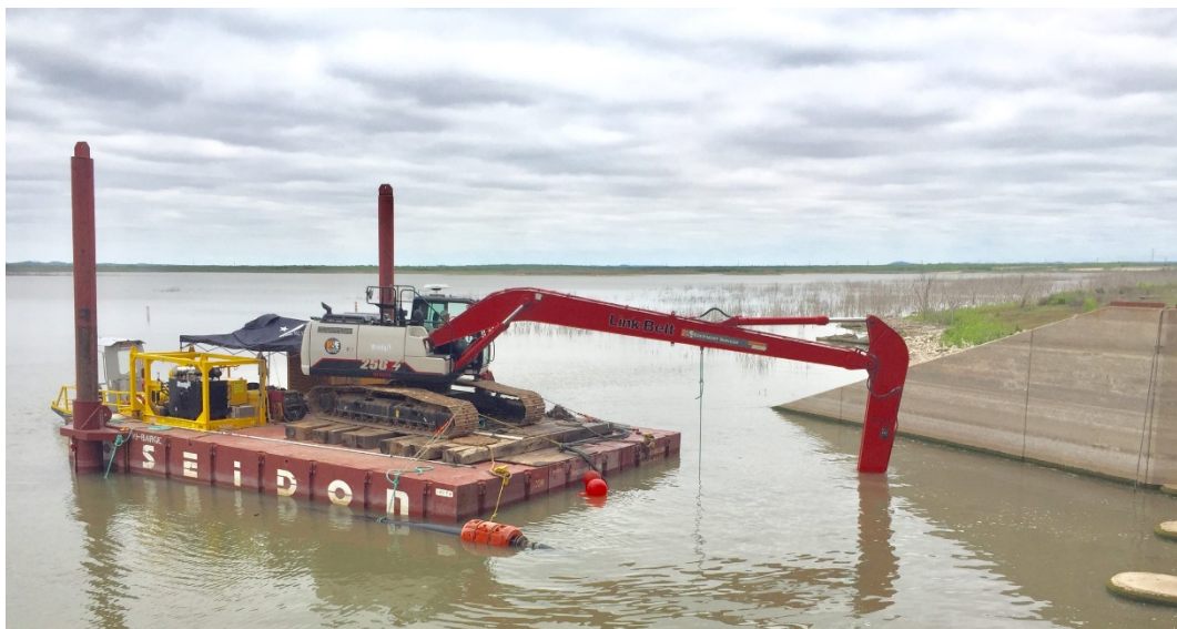
Figura 9. Escavatore su chiatta con martello demolitore (Fonte: elaborazione propria).
