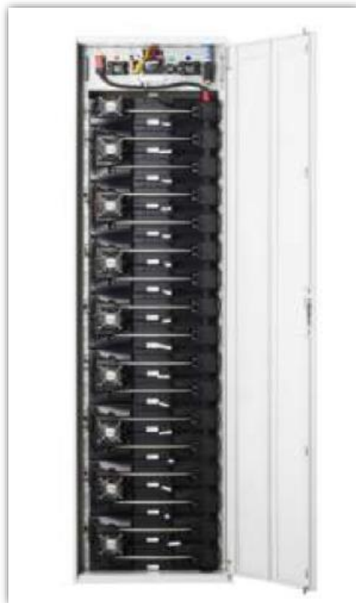
Fig. 37. Esempio rack batterie
