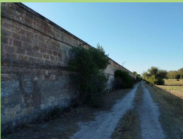
Foto 29. Muro perimetrale della ex-polveriera.
