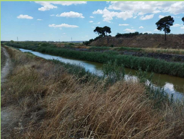
Foto 3. Canale d'Aiedda, BP dei Fiumi, torrenti e corsi d'acqua iscritti negli elenchi delle acque pubbliche, nel BP dei Territori costieri e nell'UCP delle Aree soggette a vincolo idrogeologico.
