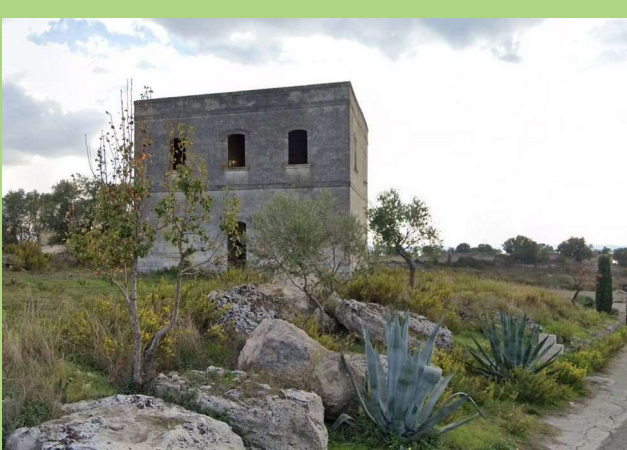
Foto 19. Casello ferroviario della linea chiusa Nasisi - Taranto Arsenale, oggetto delle misure di compensazione.
