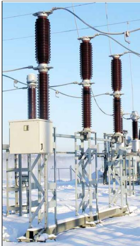
Fig. 22. Particolare Interruttore con TA incorporato.
