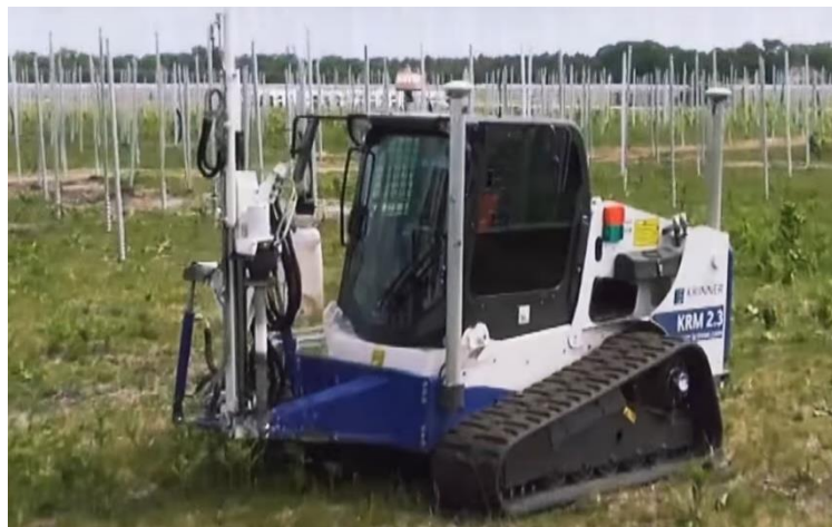
Fig. 4. Esempio di fissaggio delle strutture di supporto
