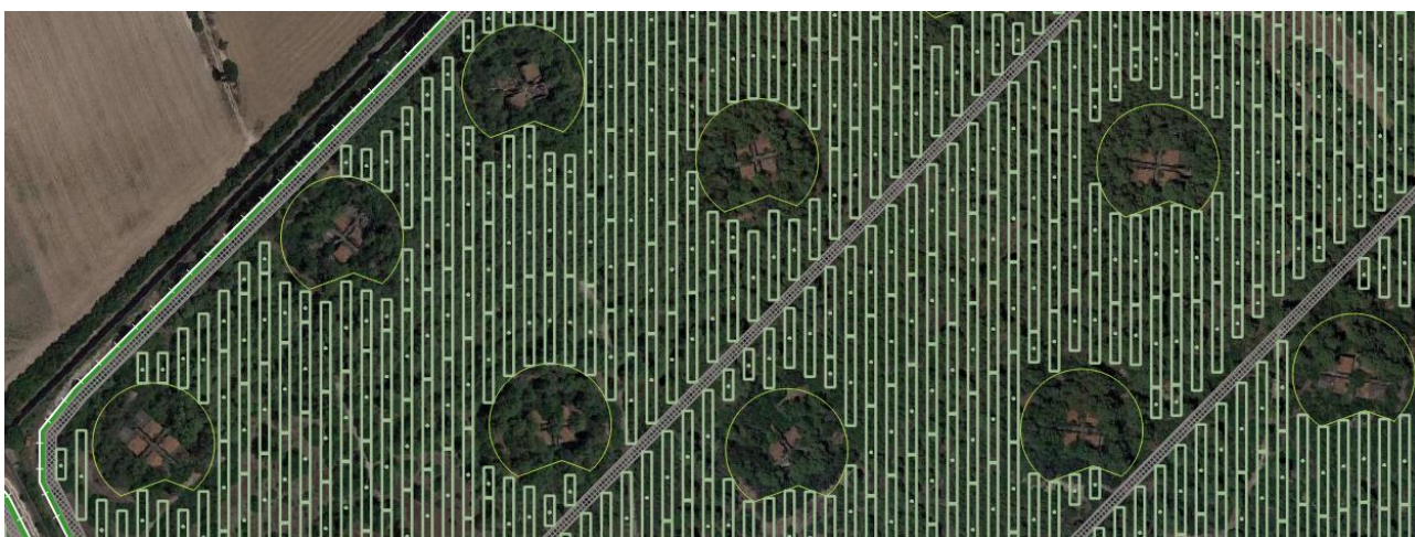
Fig. 3.3 – Elementi di discontinuità all'interno del campo fotovoltaico ex-polveriera.
