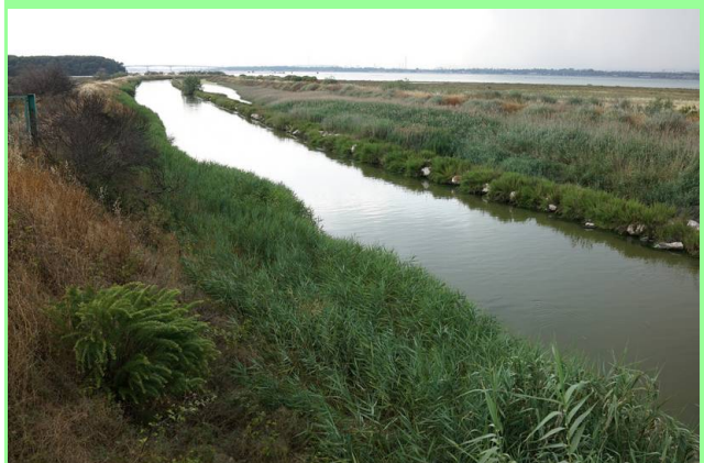
Figura 46: Canale Aiedda (Punto rilievo: W158).
