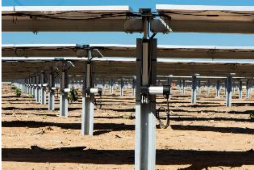
Figura 1. Palificazione tracker infissa nel terreno.
