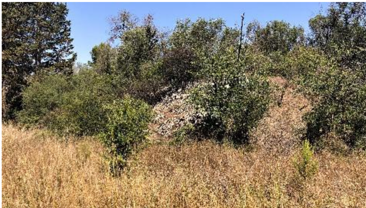
Figura 40. Area della Polveriera N. Uno dei terrapieni realizzati on l'accumulo e la sopraelevazione del terreno presente nell'area della Polveriera.
