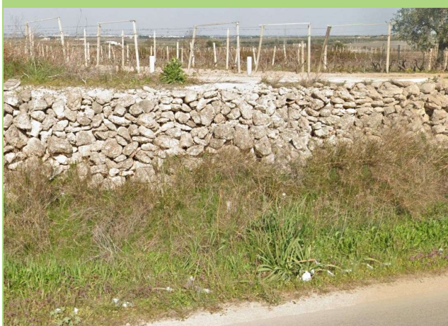
Foto 35. Muretto a secco (B.5.q) sulla SP78.
