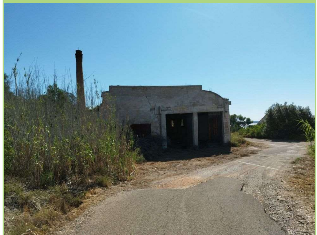
Foto 44. Fabbricati diruti nell'area DIREMUNI Taranto. Ciminiera per la produzione di materiale pirico.
