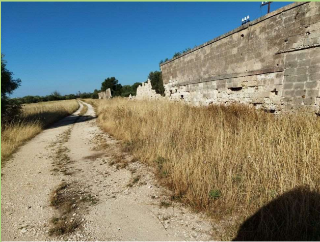
Foto 31. Muro perimetrale della ex-polveriera.
