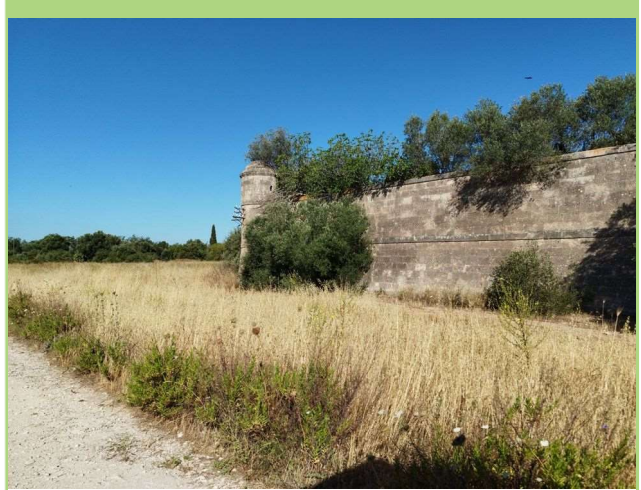
Foto 30. Torretta di avvistamento e muro perimetrale della ex-polveriera.
