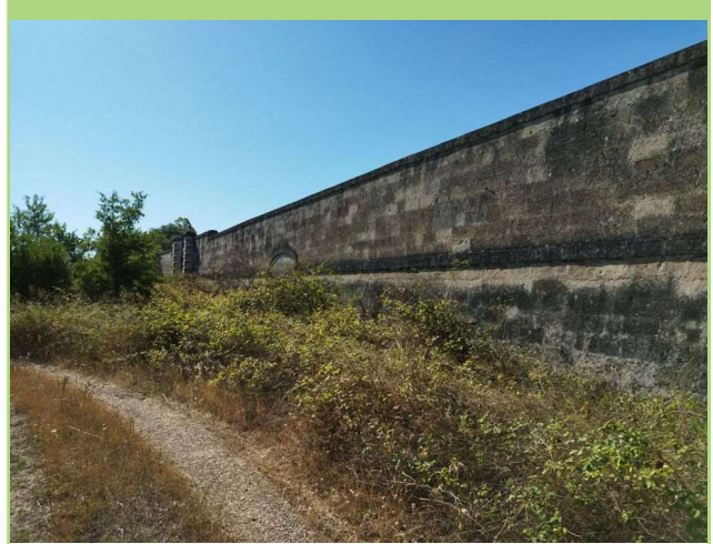
Foto 36. Muro perimetrale della ex-polveriera.
