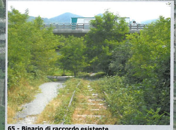
65 - Binario di raccordo esistente
