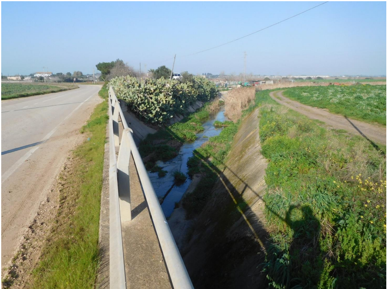
Foto Attraversamento 2 (Vista SUD-OVEST)
