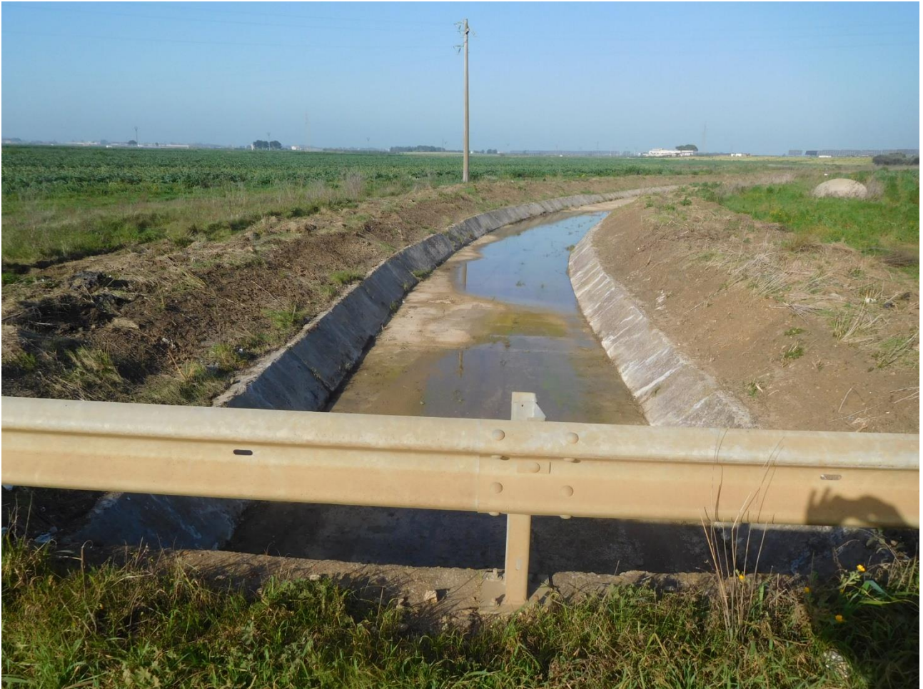
Foto Attraversamento 2 (Vista NORD-EST)
