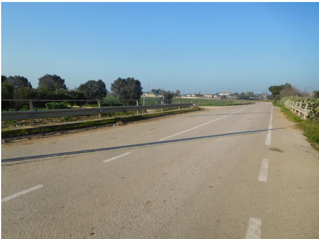
Foto Attraversamento 1 - (da SUD)
