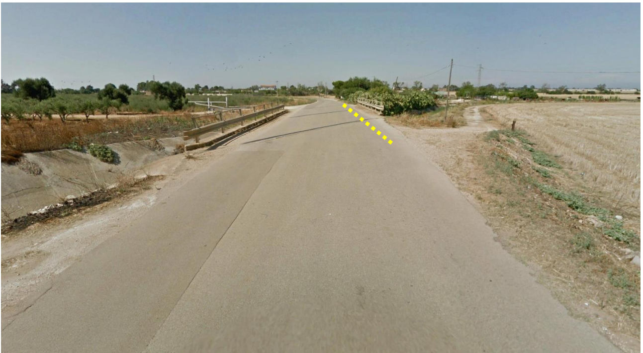
Foto Attraversamento 1 (da SUD)
