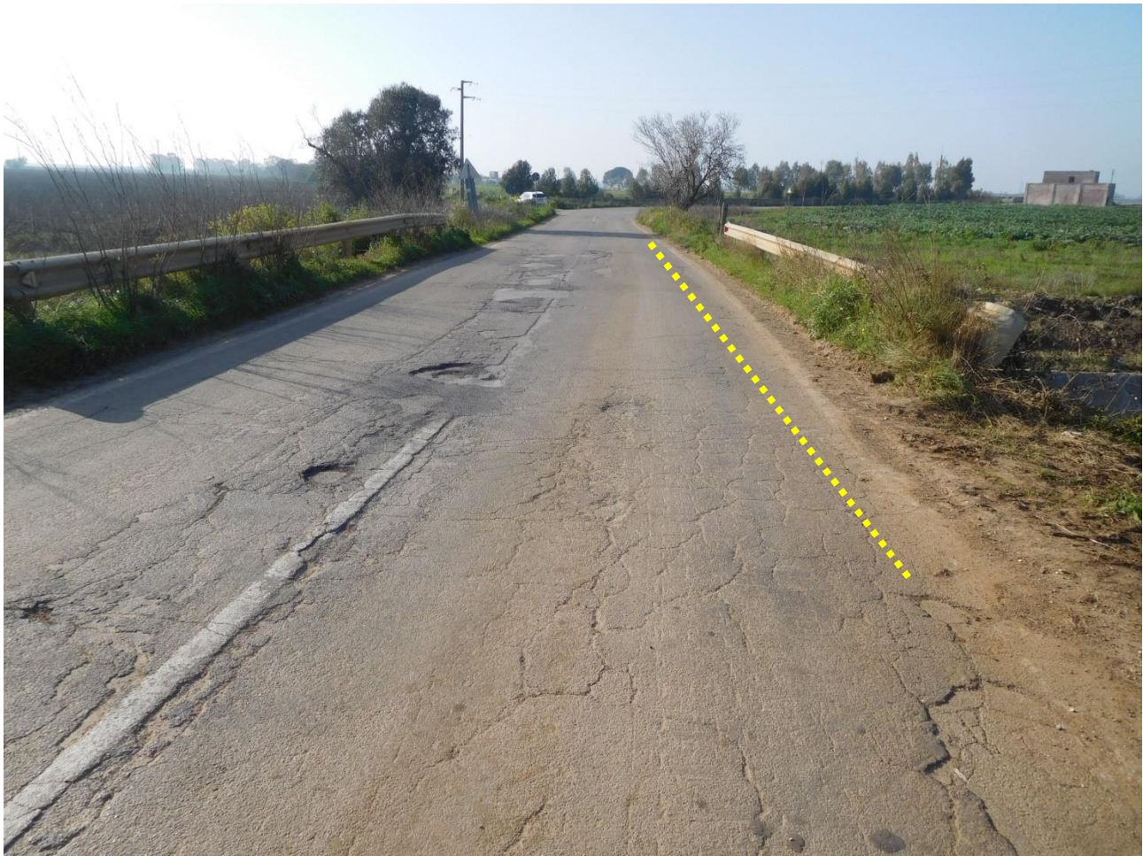
Foto Attraversamento 2 (da SUD)
