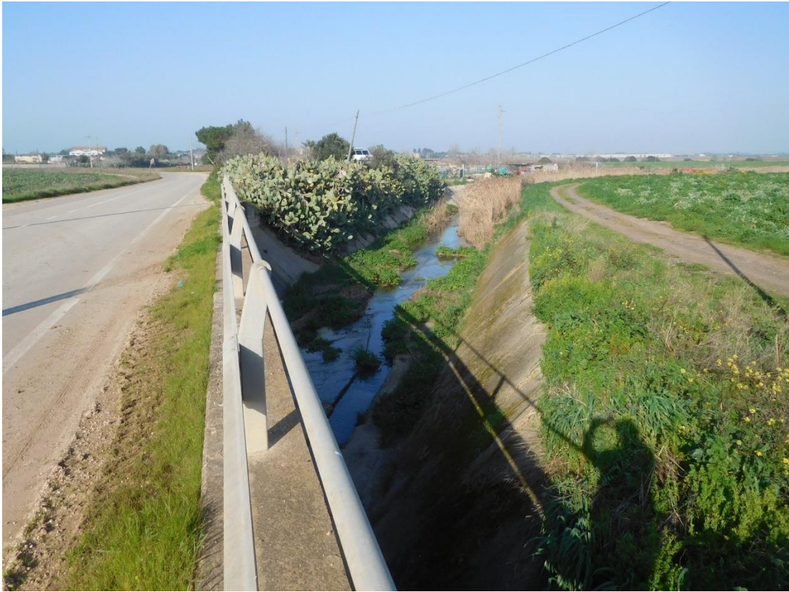
Foto Attraversamento 1 - (Lato EST)
