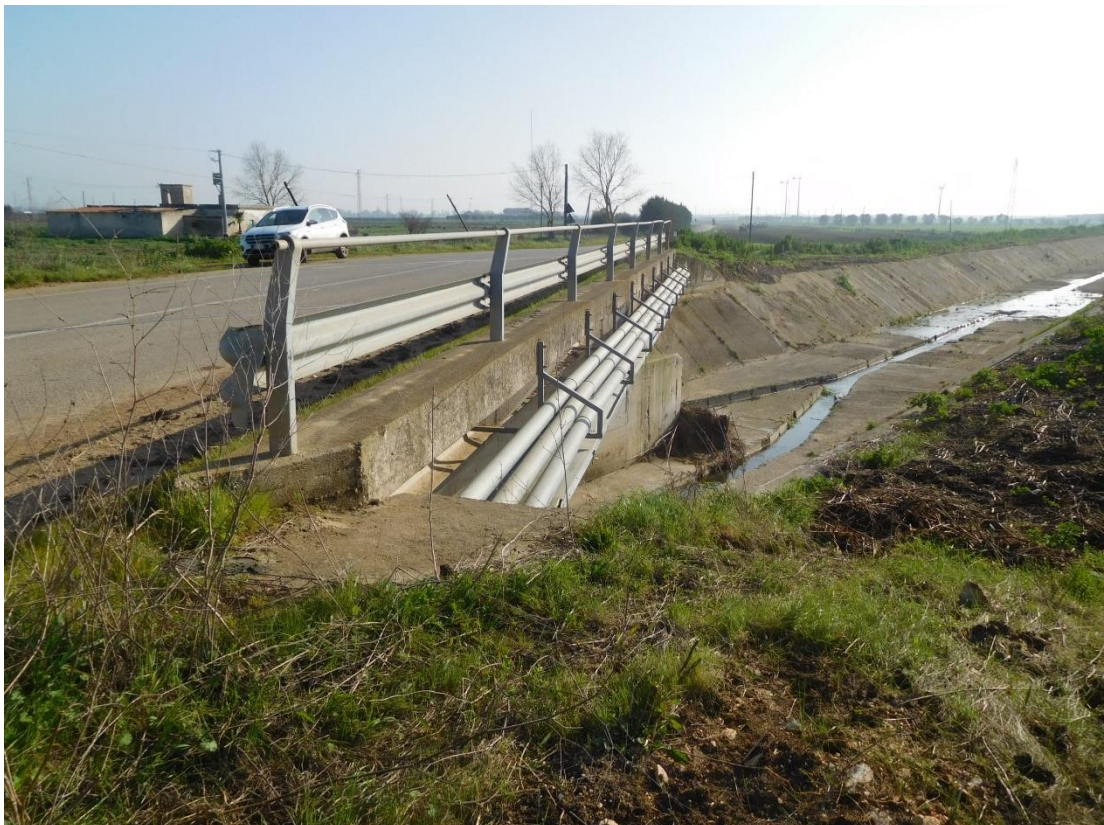
Foto Attraversamento 1 - (Lato OVEST)
