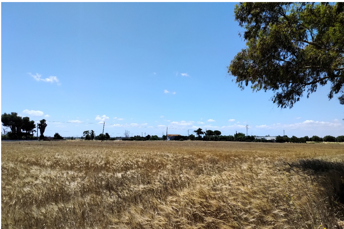
Foto-inserimento 5 - Ripresa in prossimità della Masseria Restinco a circa 650 m dal confine Nord-Est dell'area di impianto. L'impianto risulta invisibile nelle sue componenti artificiali ed anche la siepe schermante perimetrale non si intravede.
