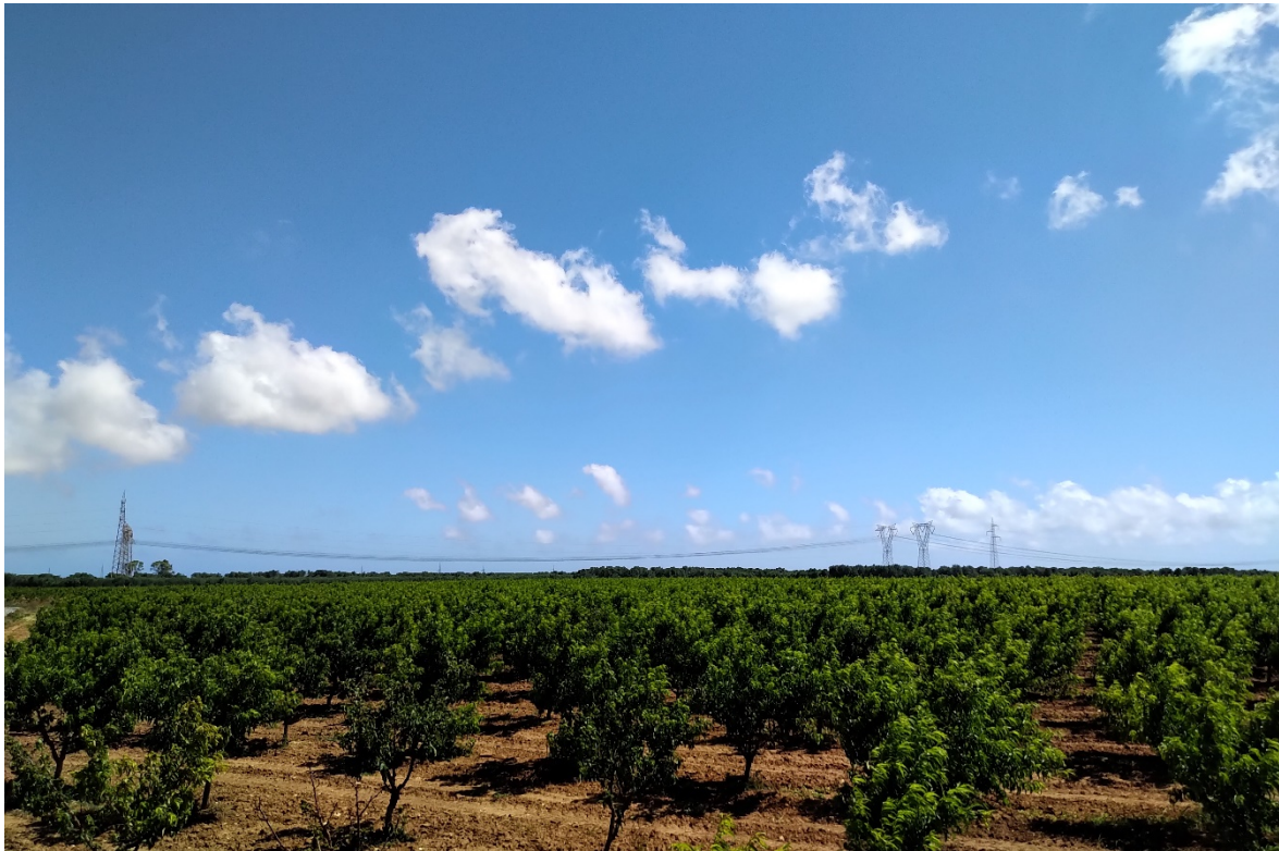
Foto 10 – Ripresa dalla strada Comunale n. 50 nei pressi della Masseria Masciullo a circa 2.400 m dal confine sud dell’impianto. Si evidenzia la presenza dell’elettrodotto aereo che dista circa 450 metri dal punto di ripresa. Vista la presenza di numerose barriere verdi l’area di installazione è di fatto invisibile.
