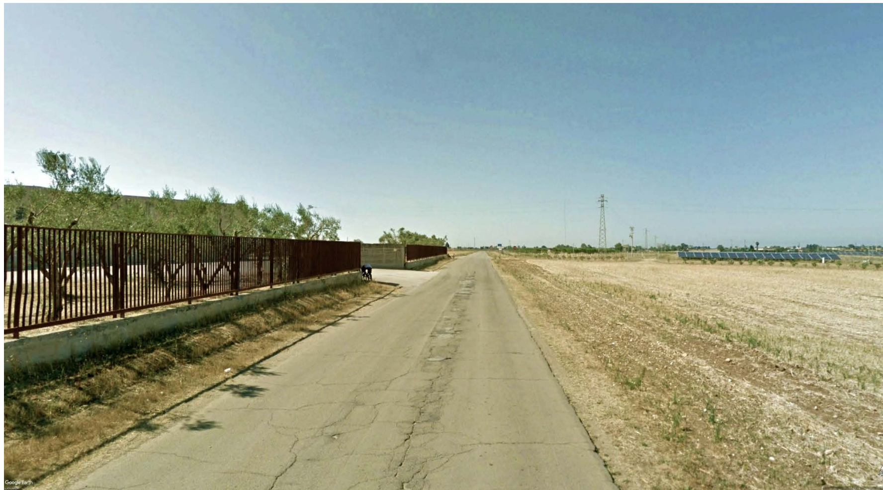
Foto 8 - Ripresa dalla SP43 (Vista SUD) a 850 metri dalla recinzione di impianto.
