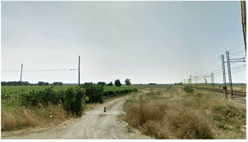
Foto 5 - Ripresa in prossimità della linea ferrata a poche decine di metri dalla recinzione di impianto. L'impianto risulta poco e parzialmente visibile nelle sue componenti artificiali (punto di ripresa h.2,5 m)
