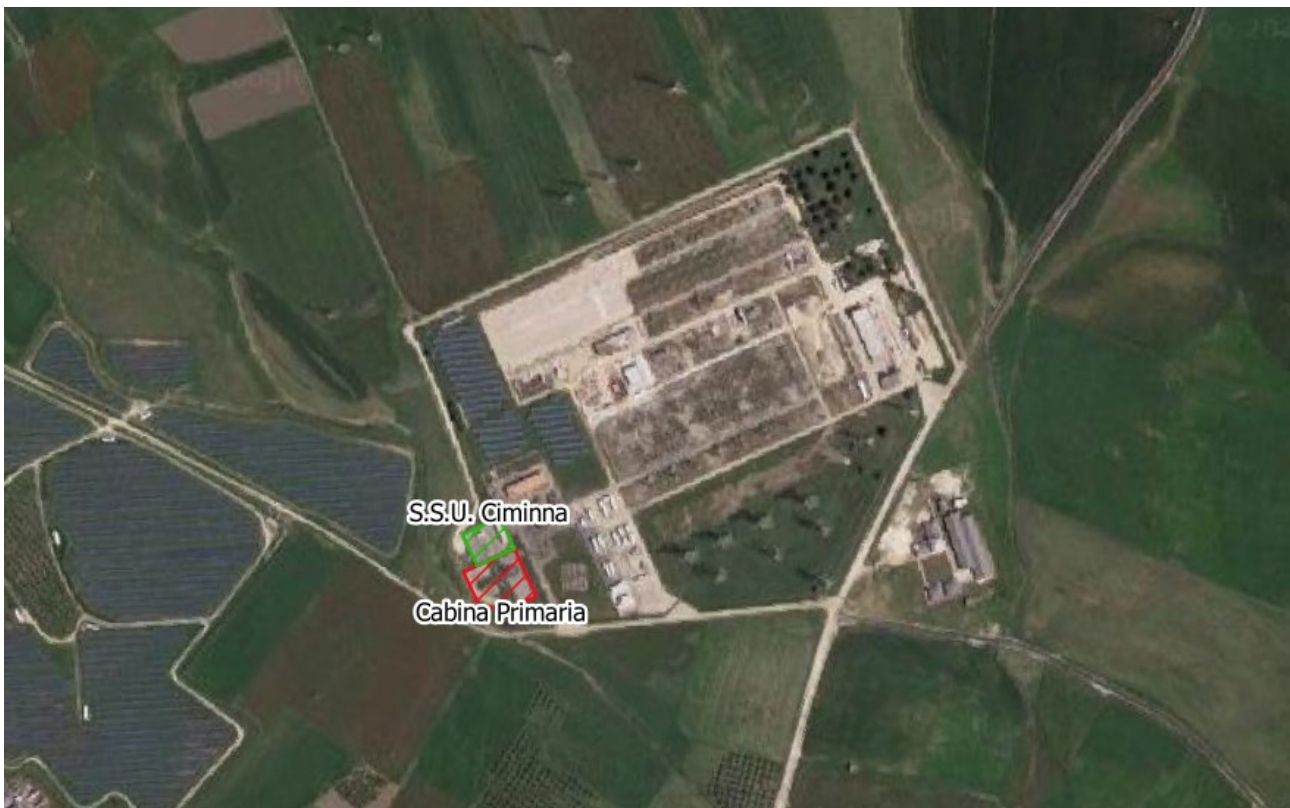
Figura 2-23: Stazione di connessione dell'impianto VRG-040
