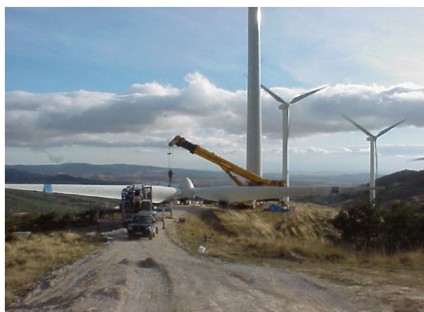
Figura 6-4: Esempio ingombro del rotore a terra
