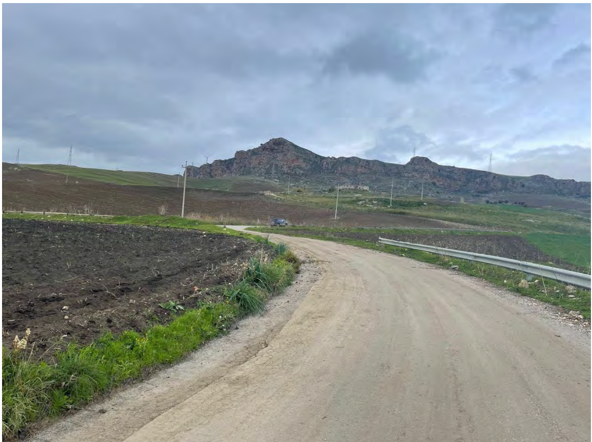
Foto 26 – Panoramica UR 07 (cavidotto)
