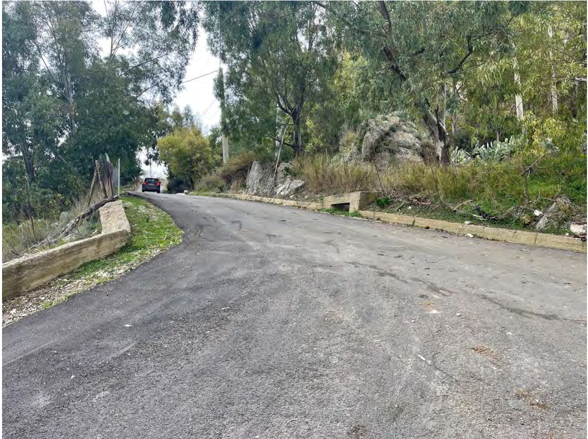
Foto 25 – Panoramica UR 07 (cavidotto)
