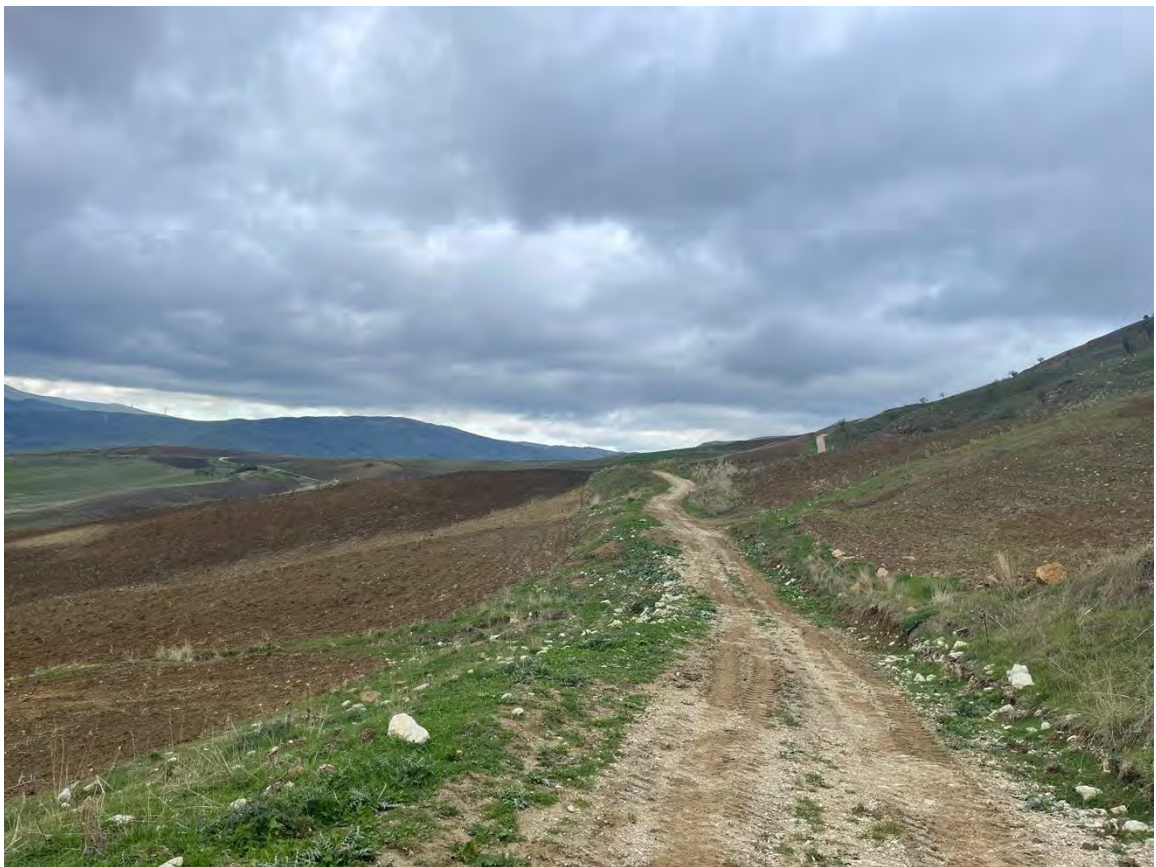
Foto 38 – Panoramica UR 08 (viabilità e cavidotto)
