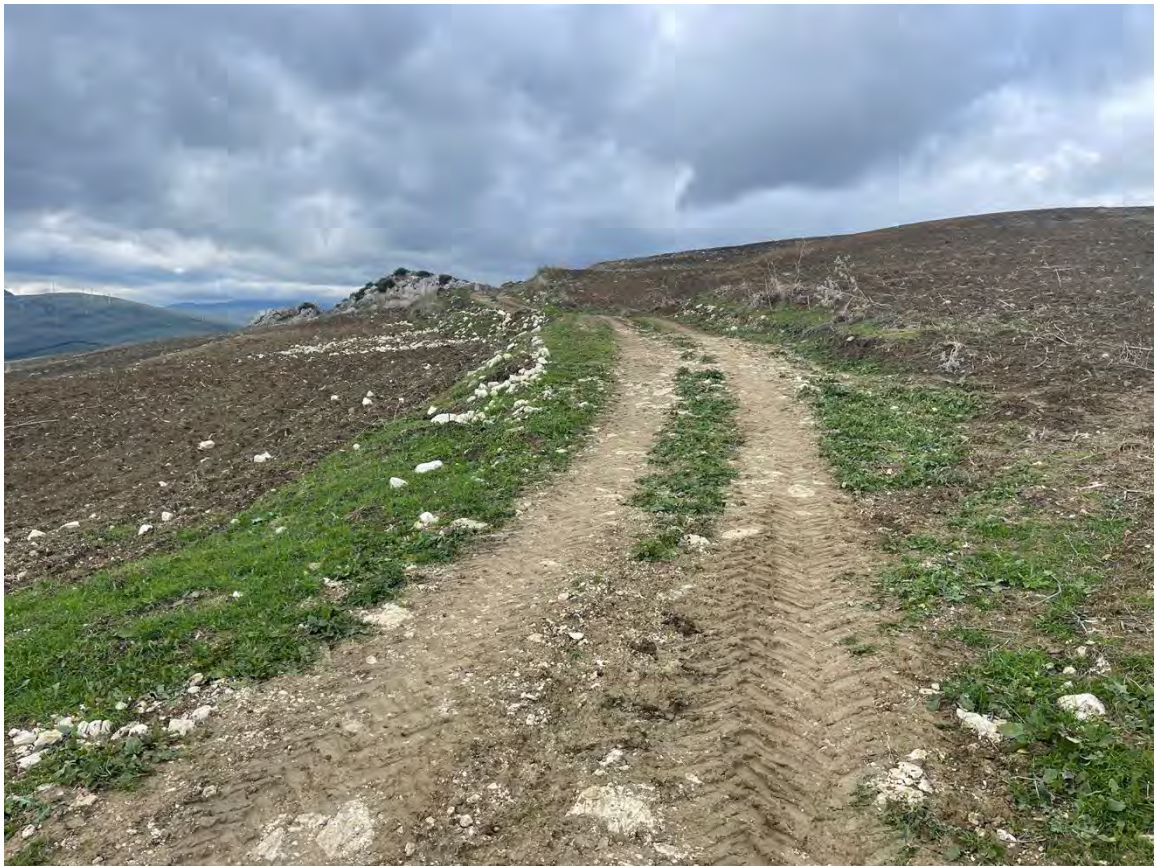
Foto 37 – Panoramica UR 08 (viabilità e cavidotto)
