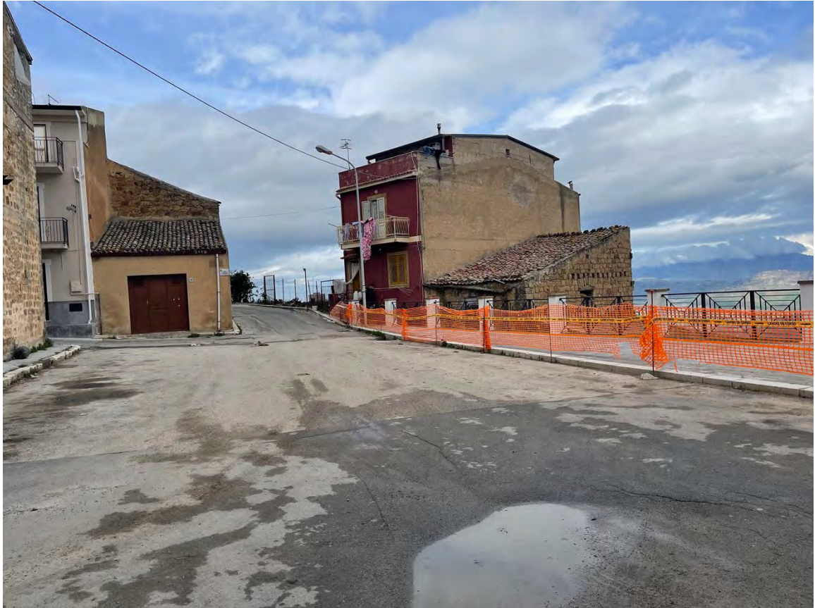
Foto 33 – Panoramica UR 07 (cavidotto)
