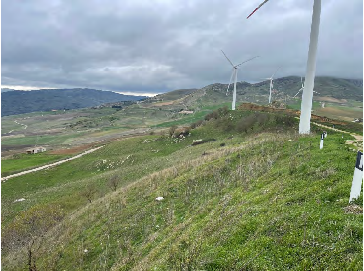
Foto 57 – Panoramica UR 14 (aerogeneratore CF-01_r)
