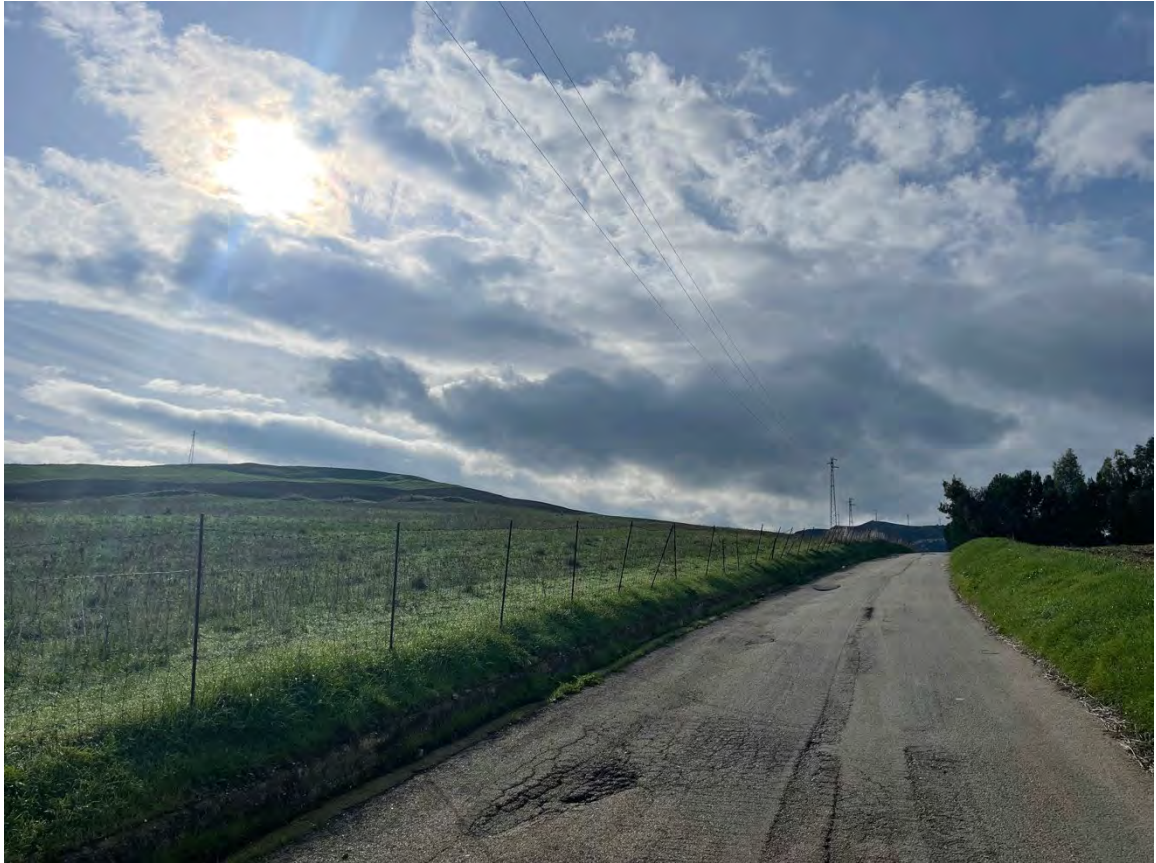
Foto 29 – Panoramica UR 07 (cavidotto)
