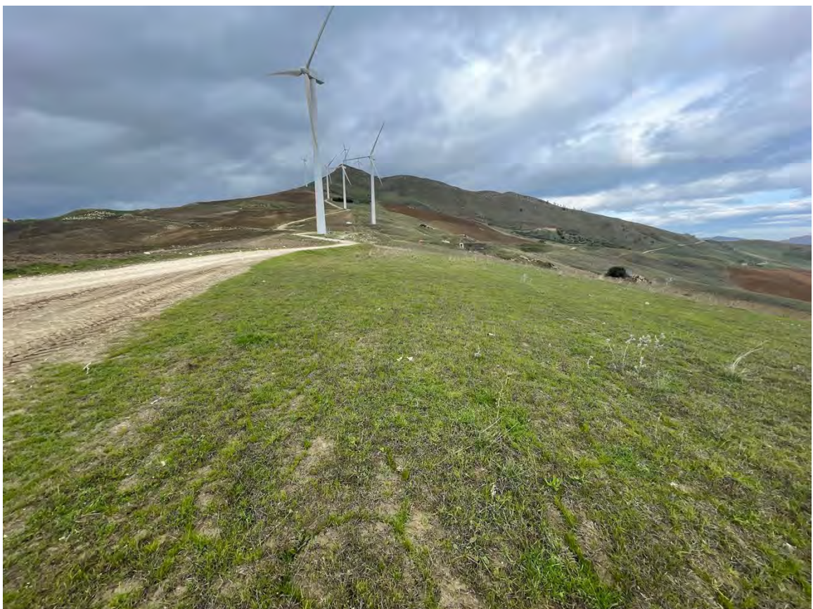
Foto 44 – Panoramica UR 10 (aerogeneratore CF-04_r)
