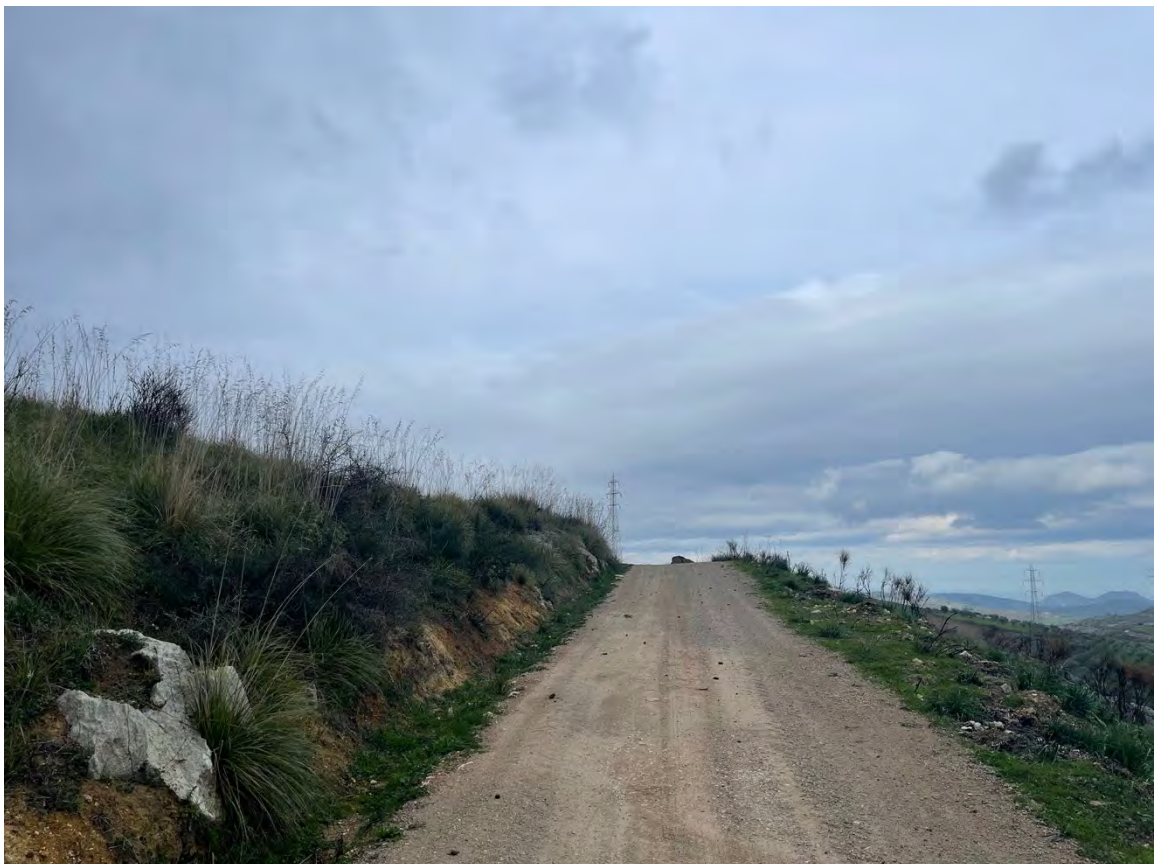
Foto 24 – Panoramica UR 06 (cavidotto)
