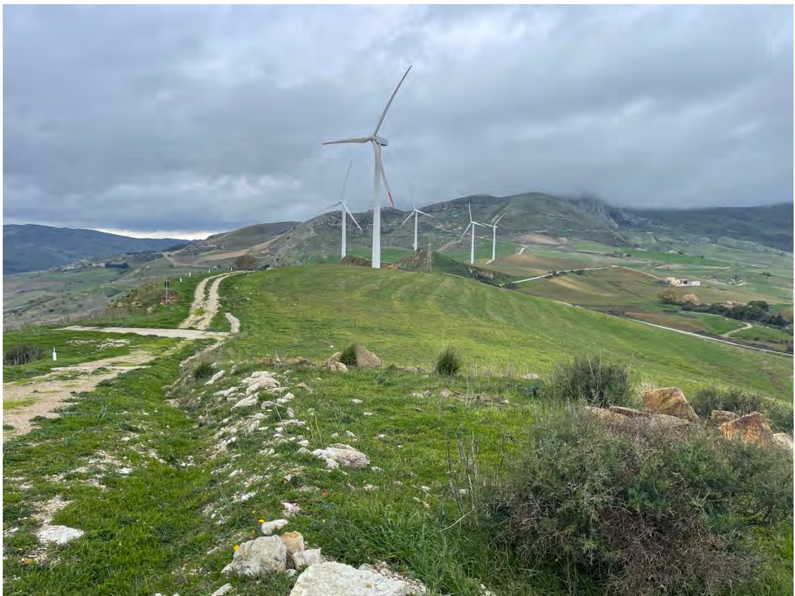
Foto 56 – Panoramica UR 14 (aerogeneratore CF-01_r)
