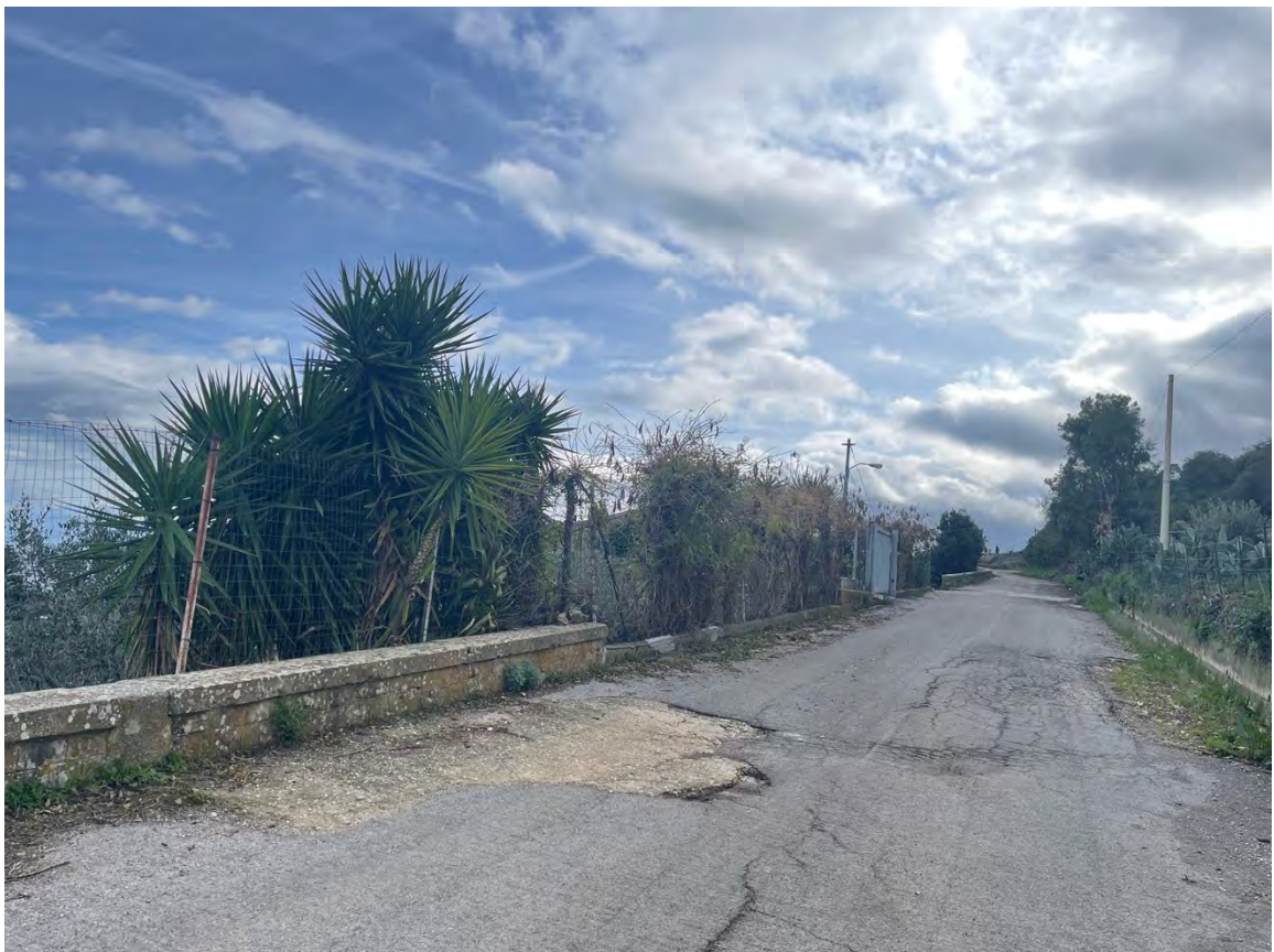
Foto 32 – Panoramica UR 07 (cavidotto)
