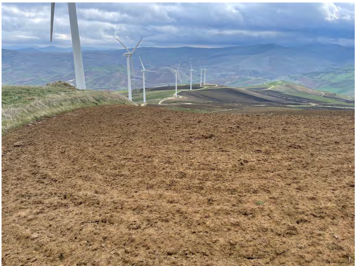
Foto 42 – Panoramica UR 09 (aerogeneratore CF-03_r)
