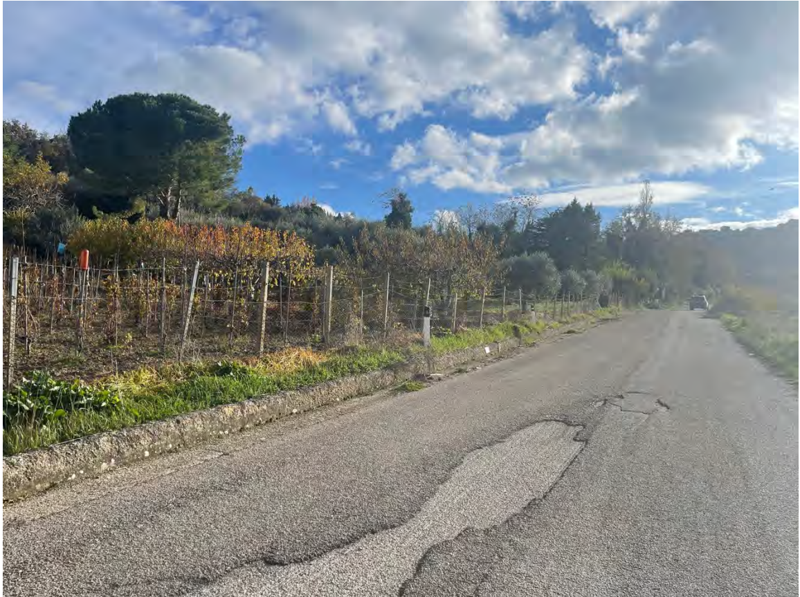
Foto 59 – Panoramica UR 15 (aerogeneratore CF-06_r)
