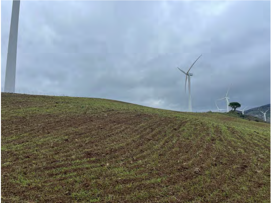
Foto 55 – Panoramica UR 14 (aerogeneratore CF-01_r)
