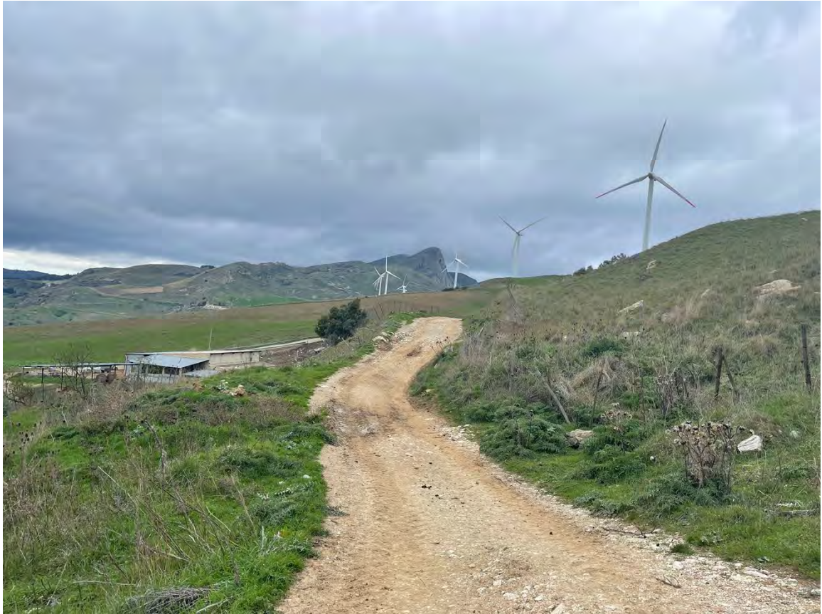
Foto 39 – Panoramica UR 08 (viabilità e cavidotto)
