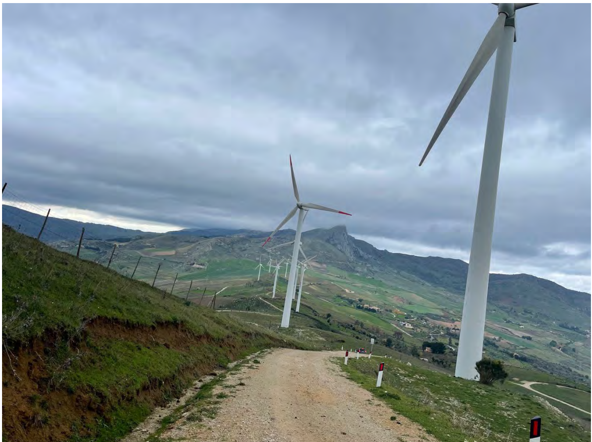
Foto 52 – Panoramica UR 13 (aerogeneratore CF-07_r)
