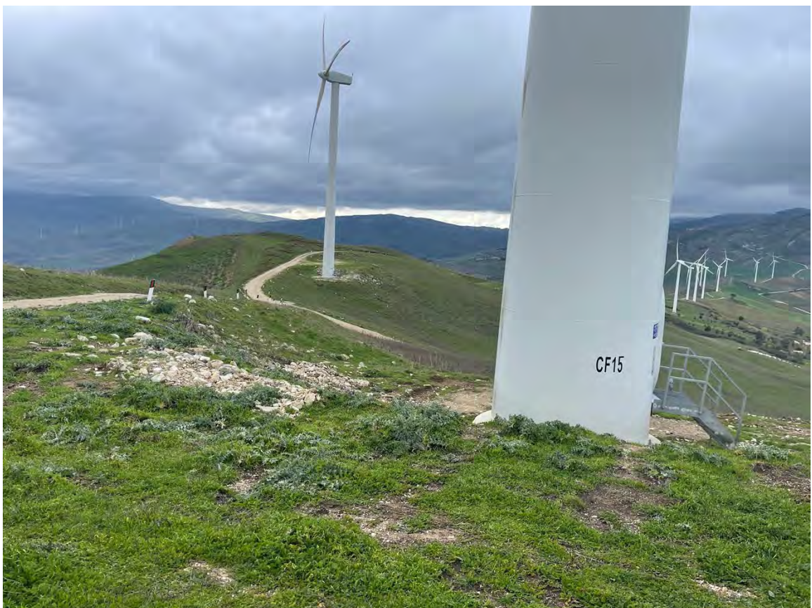
Foto 50 – Panoramica UR 12 (aerogeneratore CF-02_r)
