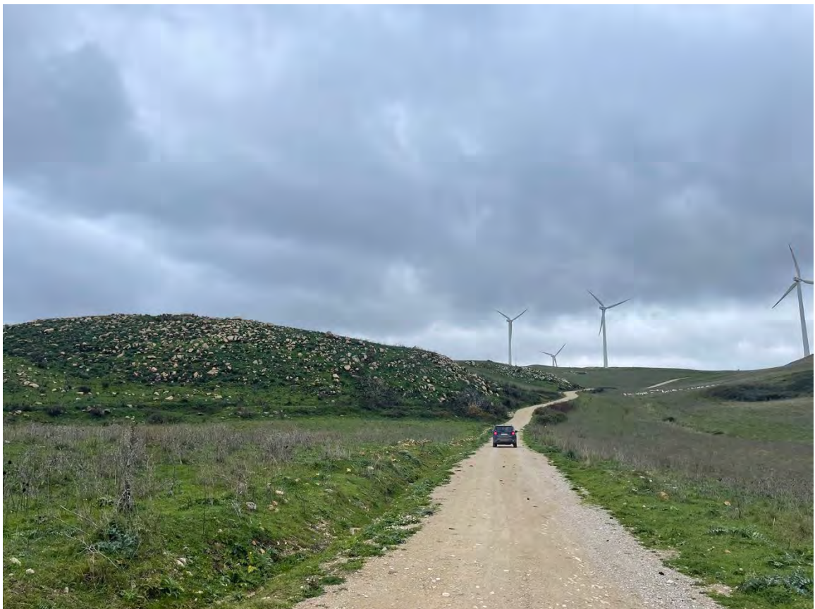
Foto 54 – Panoramica UR 13 (aerogeneratore CF-07_r)
