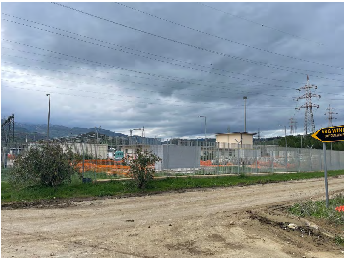
Foto 28 – Panoramica UR 07 (Sottostazione Utente Ciminna)
