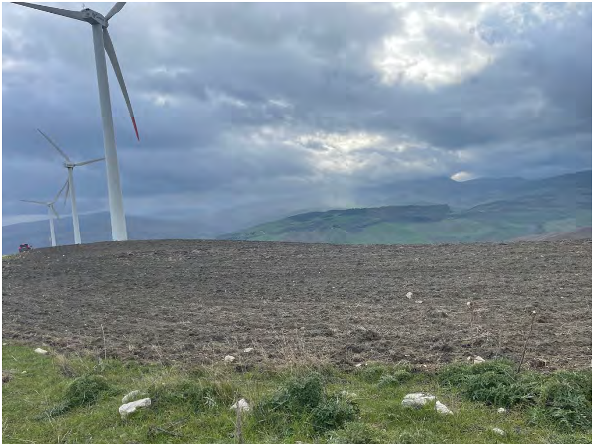
Foto 43 – Panoramica UR 10 (aerogeneratore CF-04_r)
