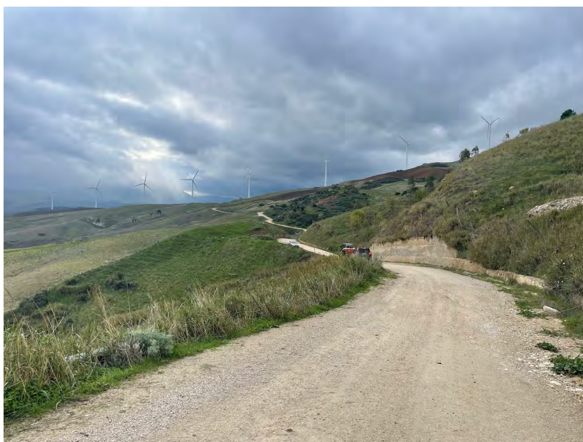
Foto 36 – Panoramica UR 08 (viabilità e cavidotto)
