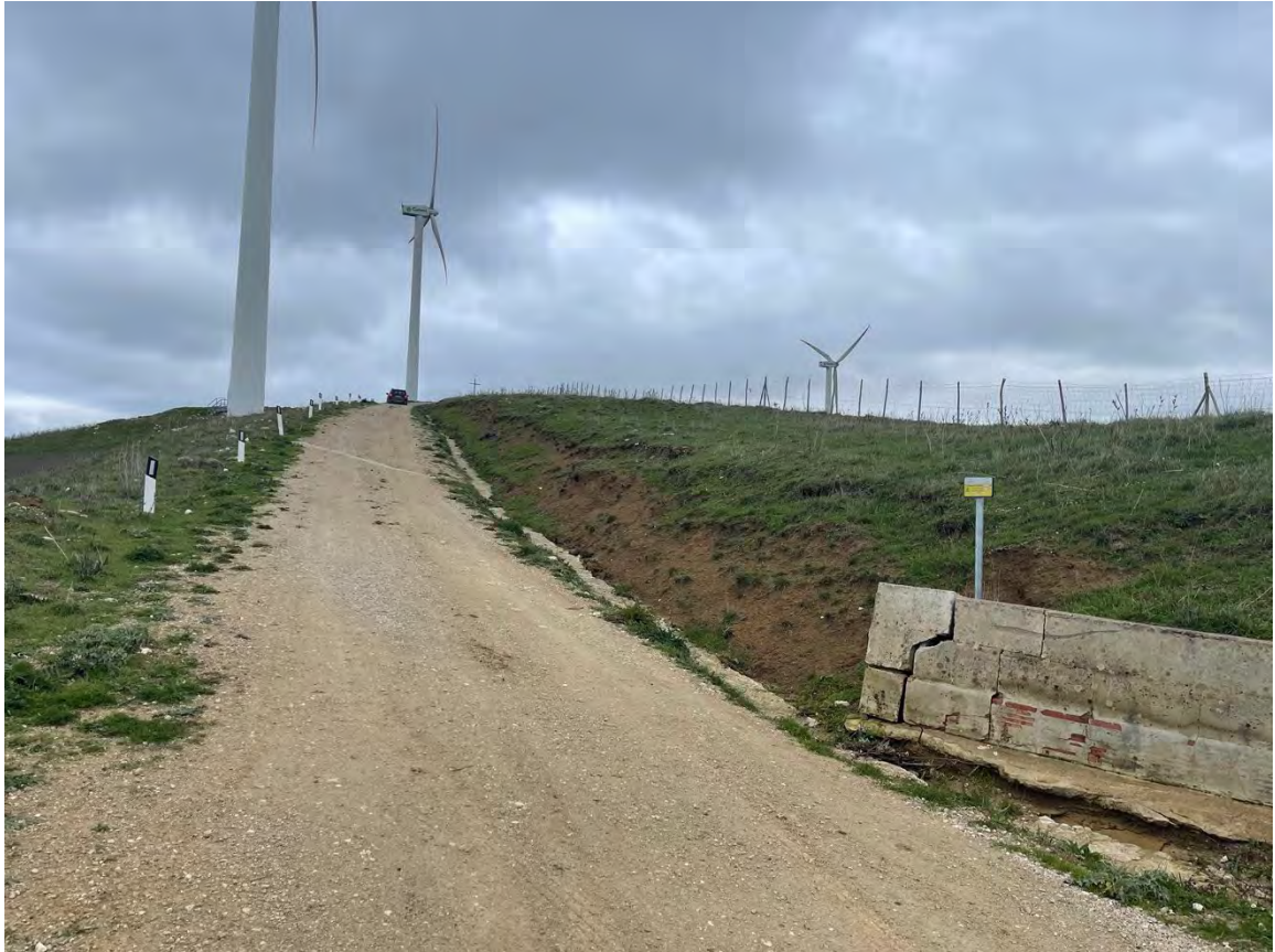
Foto 51 – Panoramica UR 12 (aerogeneratore CF-02_r)
