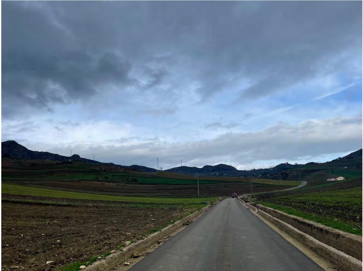
Foto 27 – Panoramica UR 07 (cavidotto)
