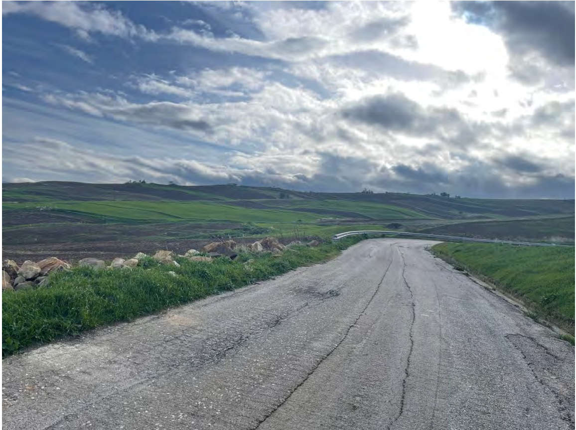
Foto 31 – Panoramica UR 07 (cavidotto)
