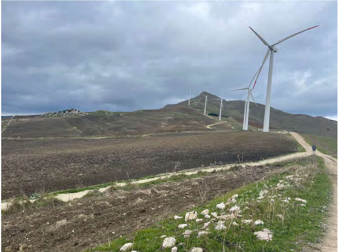
Foto 45 – Panoramica UR 10 (aerogeneratore CF-04_r)
