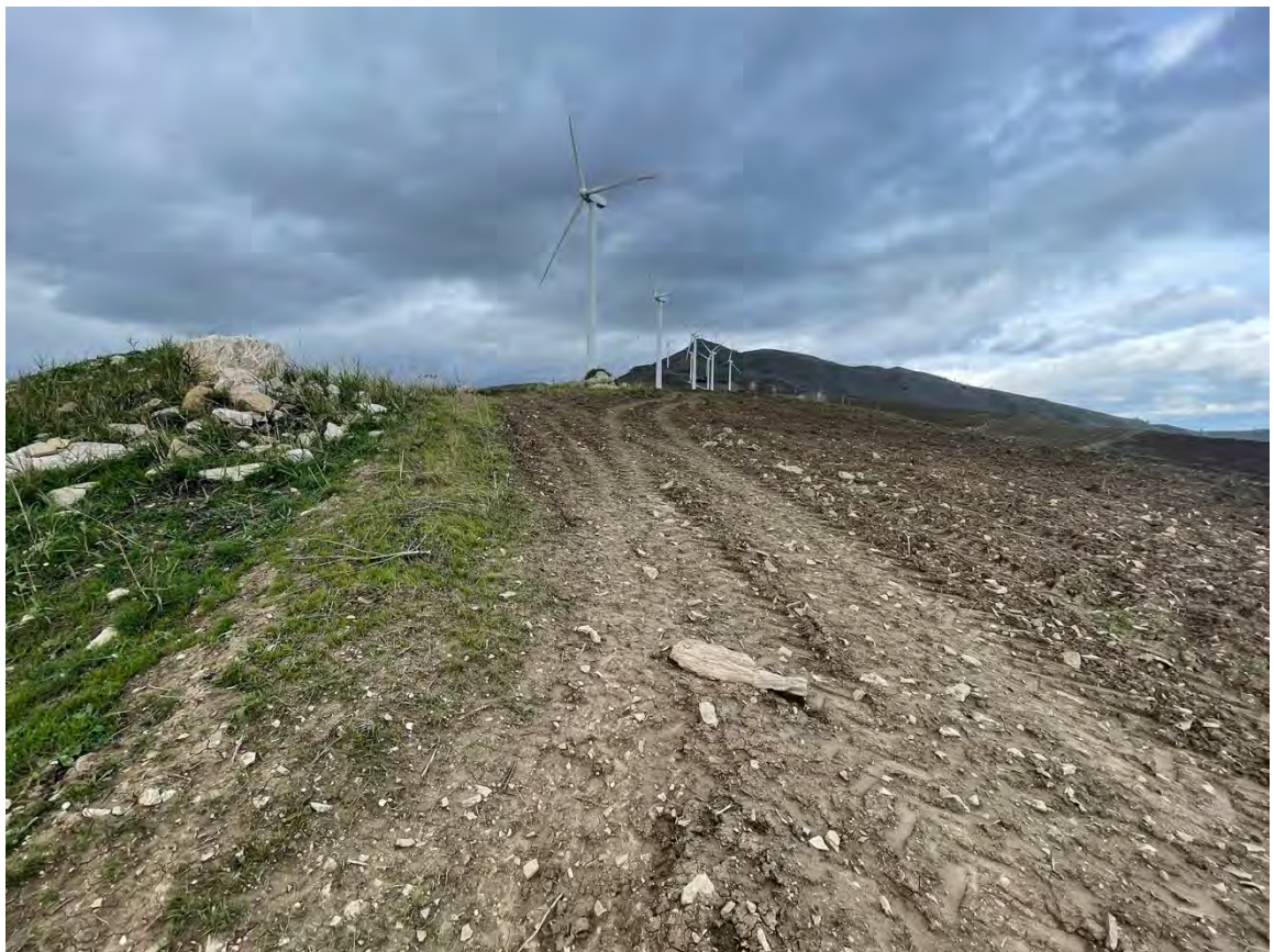
Foto 48 – Panoramica UR 11 (aerogeneratore CF-05_r)
