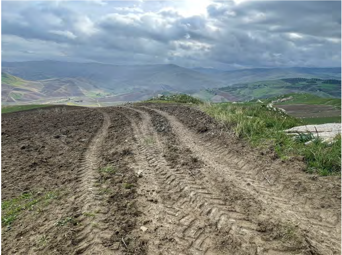
Foto 47 – Panoramica UR 11 (aerogeneratore CF-05_r)
