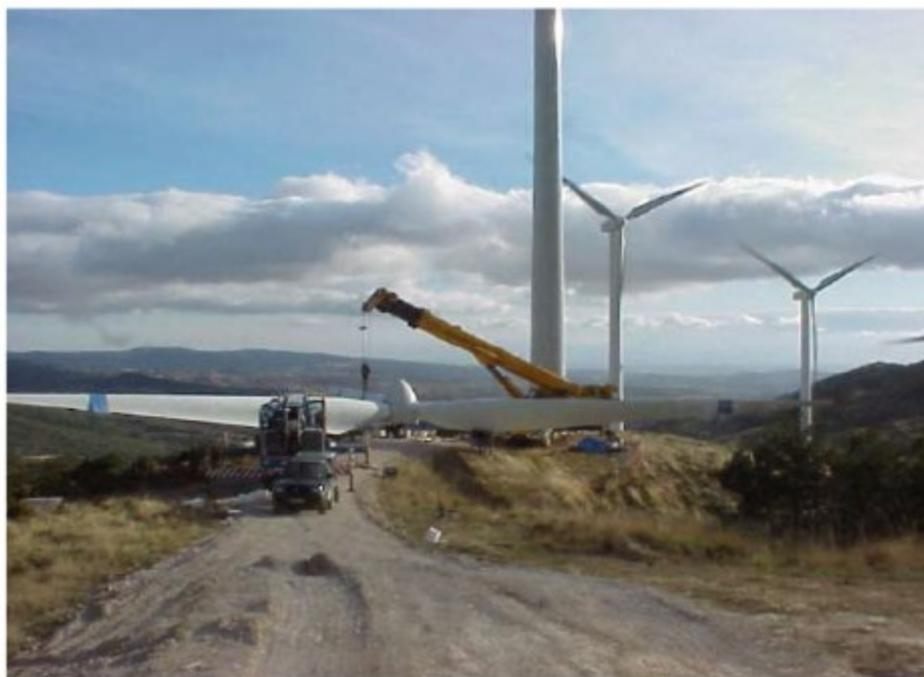
**Figura 4-5: Esempio ingombro del rotore a terra**
