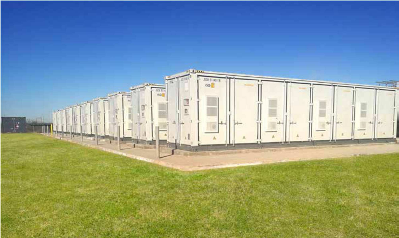
Figura 12. Esempio container di accumulo climatizzato del tipo ISO 20ft e capacità di circa 1,5 MWh
