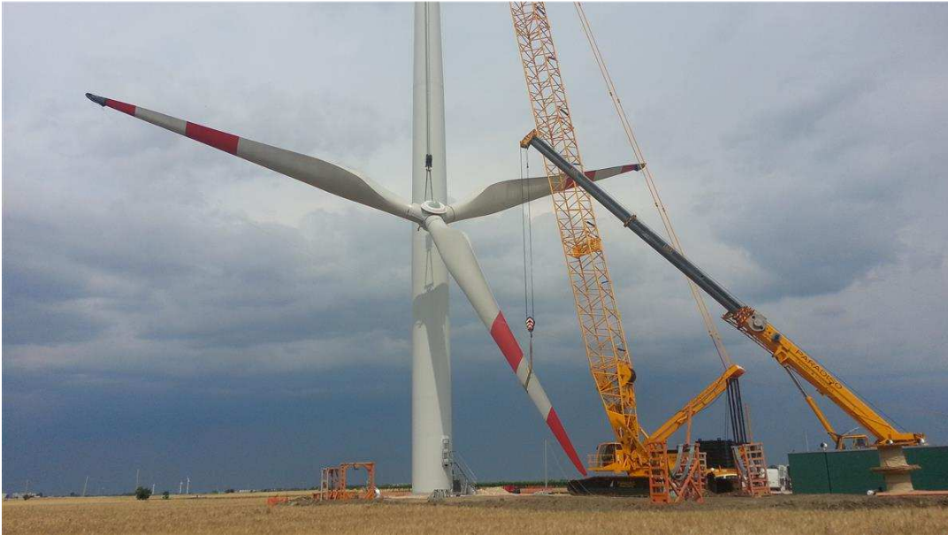
Figura 2. Smontaggio delle pale
