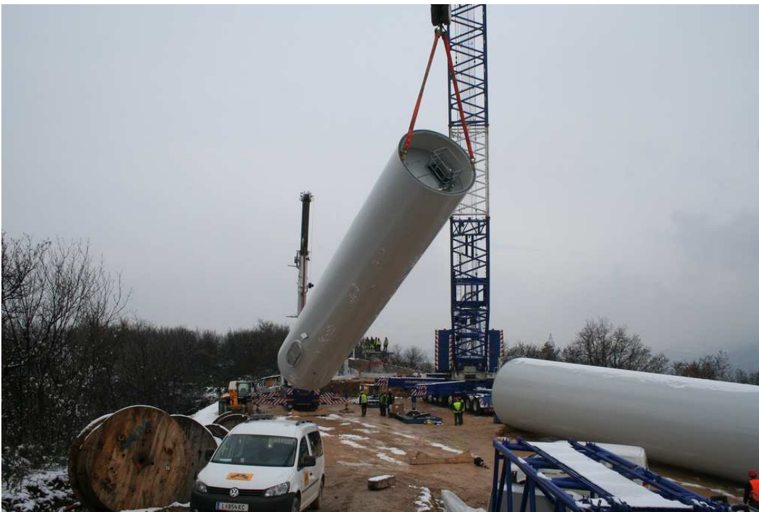
Figura 3. Smontaggio dei tronchi
