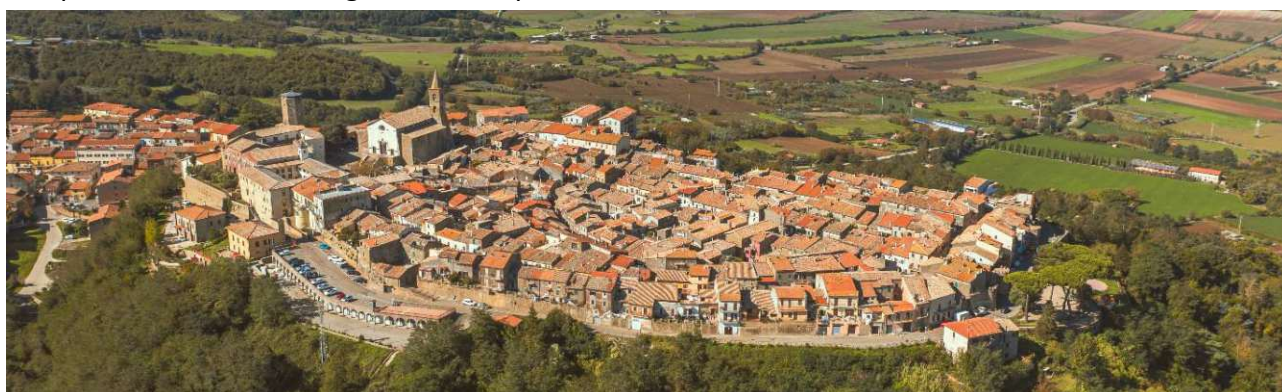
Figura 46 – Vista dal drone – Centro urbano di Valentano
