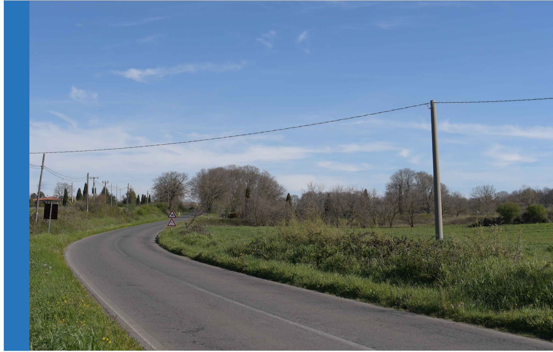
Foto 5: Stato di fatto
