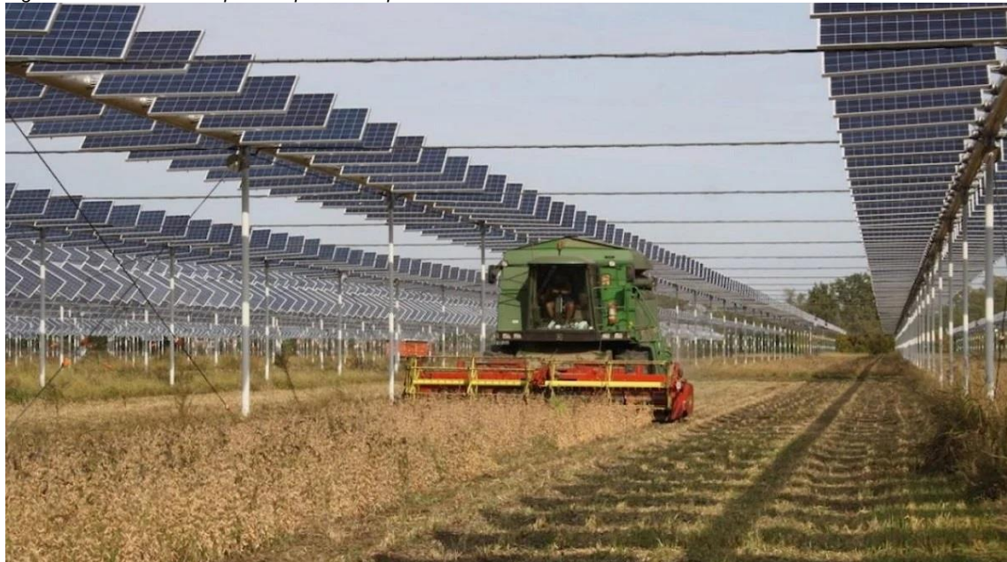
Figura 4.2a Esempio di impianto che permette la raccolta meccanica dei cereali
