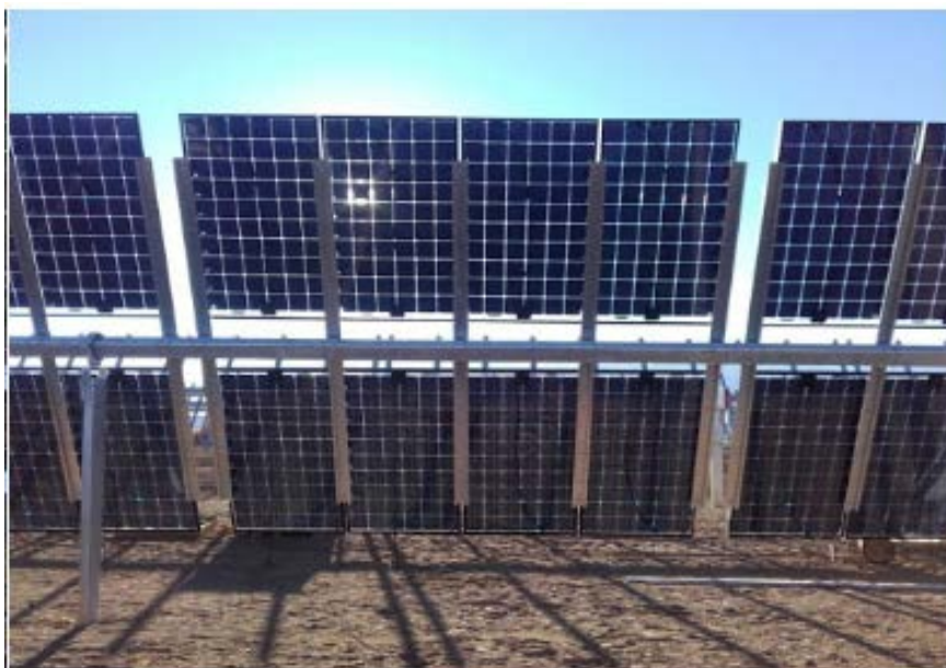
Figura 1 - Inseguitore mono-assiale tipo
