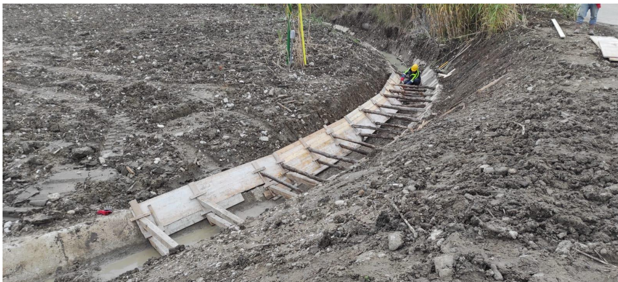
Fig. 1 – Ripristino canale irriguo
