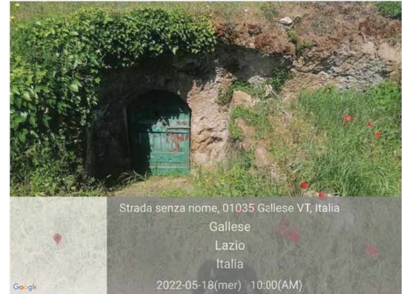
L'ingresso di una cavità che non è stato possibile ispezionare
