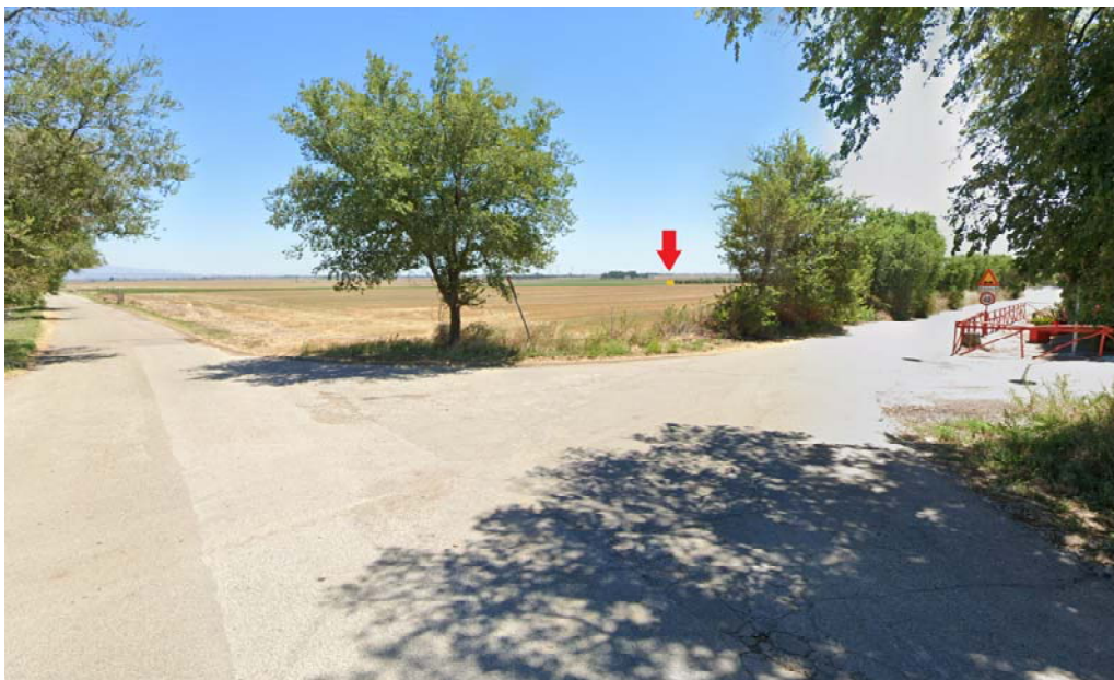
Stato di progetto: Sottostazione utente 30/36kV appena percettibile in lontananza.
