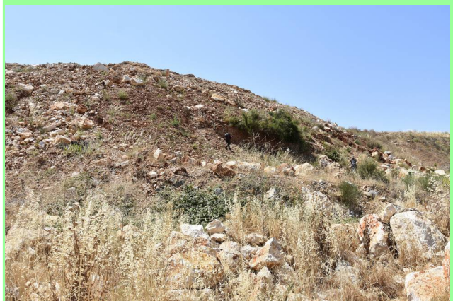
Figura 14: Deposito dell'attività di cava (Punto rilievo: W46).
