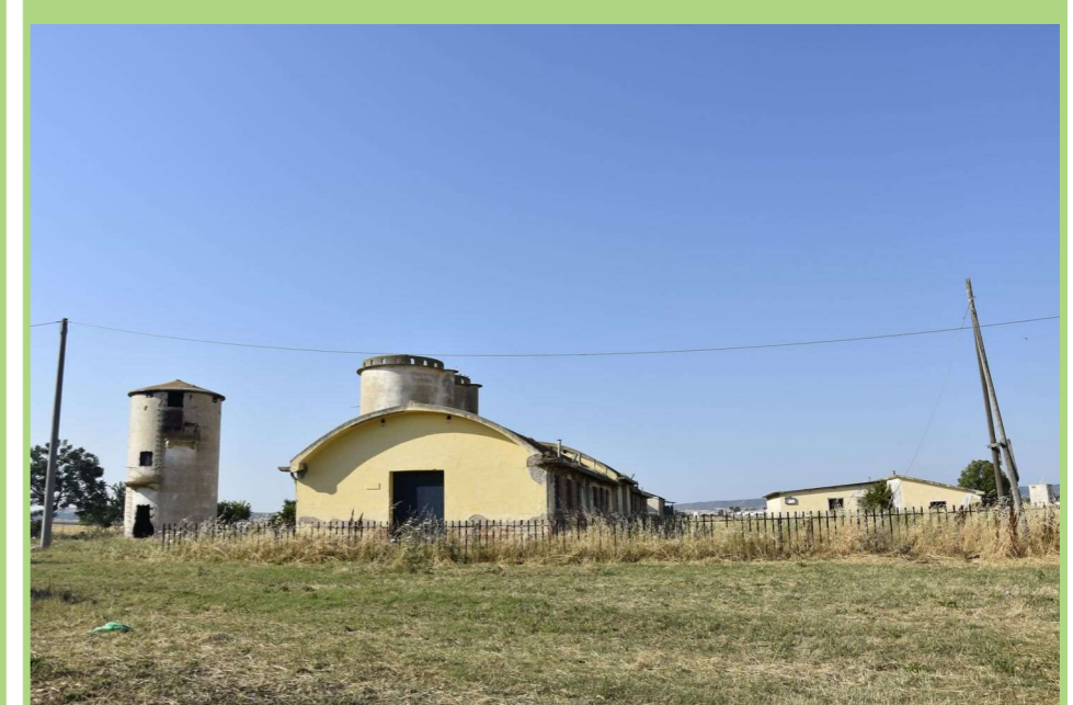
Foto 25. Podere Camilli, all'interno della zona "D" industriale.
