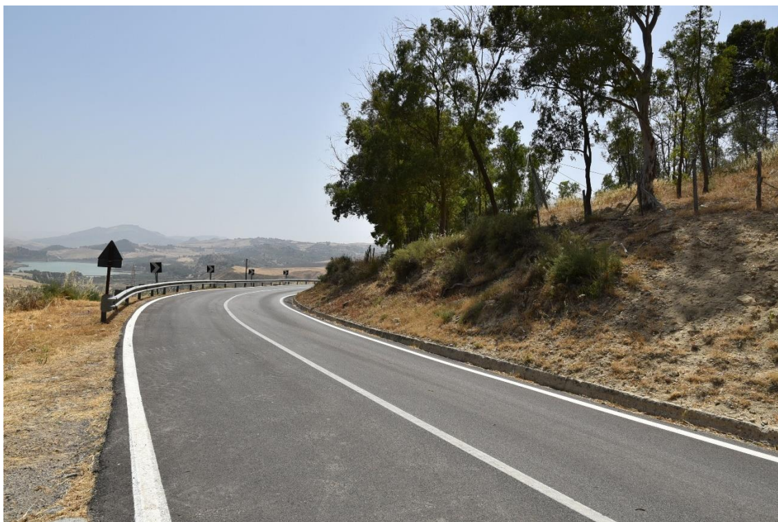
SS 290 - (Fonte: Sopralluogo giugno 2022)
