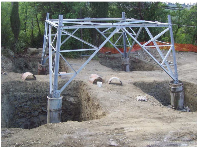
Figura 3.20: Realizzazione di fondazioni superficiali tipo CR per un sostegno a traliccio. Nell'immagine si possono osservare le quattro buche, la base del sostegno collegata alla fondazione tramite i “monconi” ed i casseri utilizzati per i quattro “colonnini” (immagine d'archivio)
