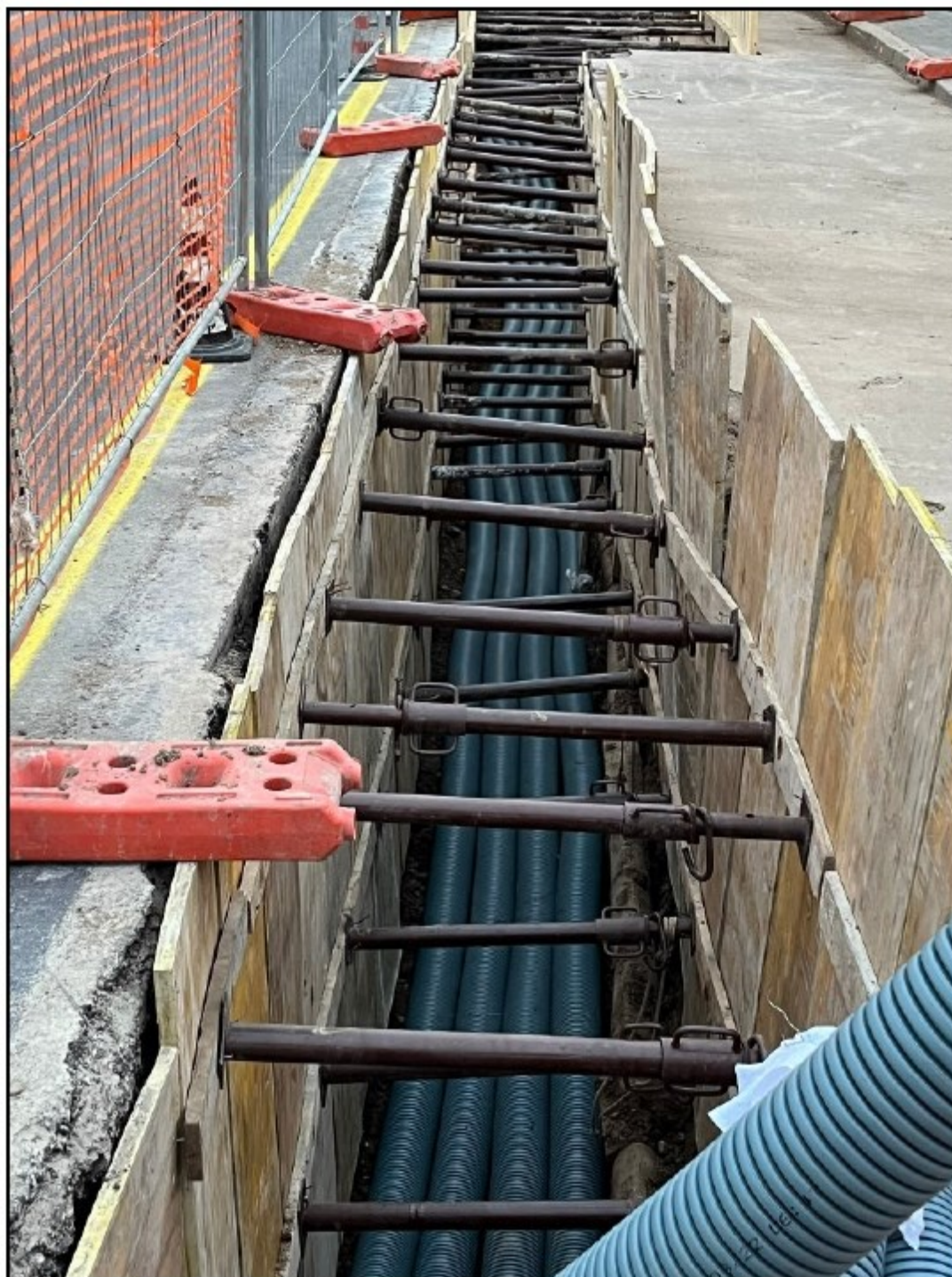
Figura 3.23: Realizzazione elettrodotta interrato. Fase di scavo predisposizione tubiere di alloggiamento cavi AT (immagine d'archivio)
