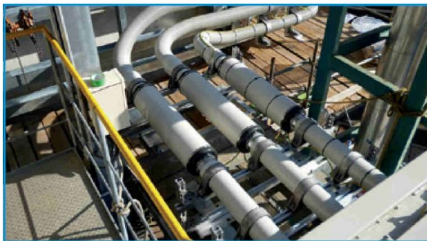
Figura 3.9: Esempio di installazione Sistema IPB (Isolated Phase Bus) – fonte: Duresca ® Bus bar system (Moser Glaser)
