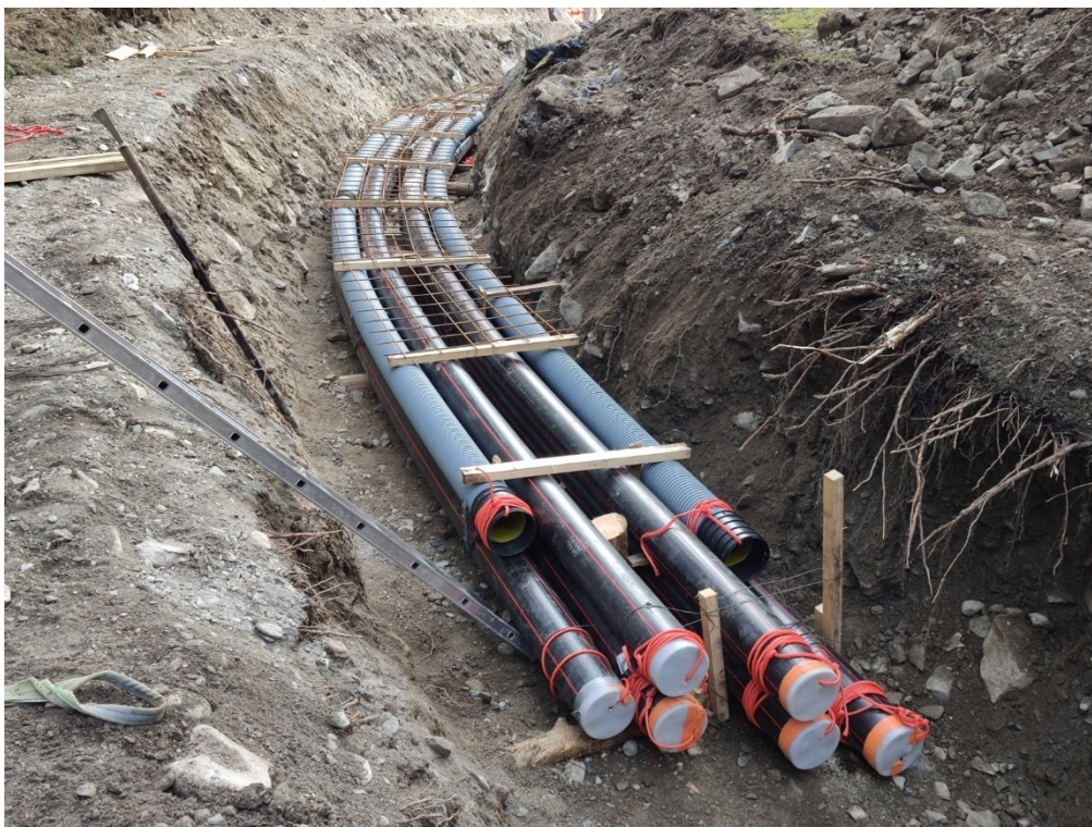
Figura 3.8: Esempio di posa in trincea
