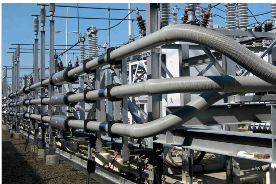
Figura 3.10: Esempio di installazione Sistema IPB (Isolated Phase Bus) – fonte: Duresca ® Bus bar system (Moser Glaser)
