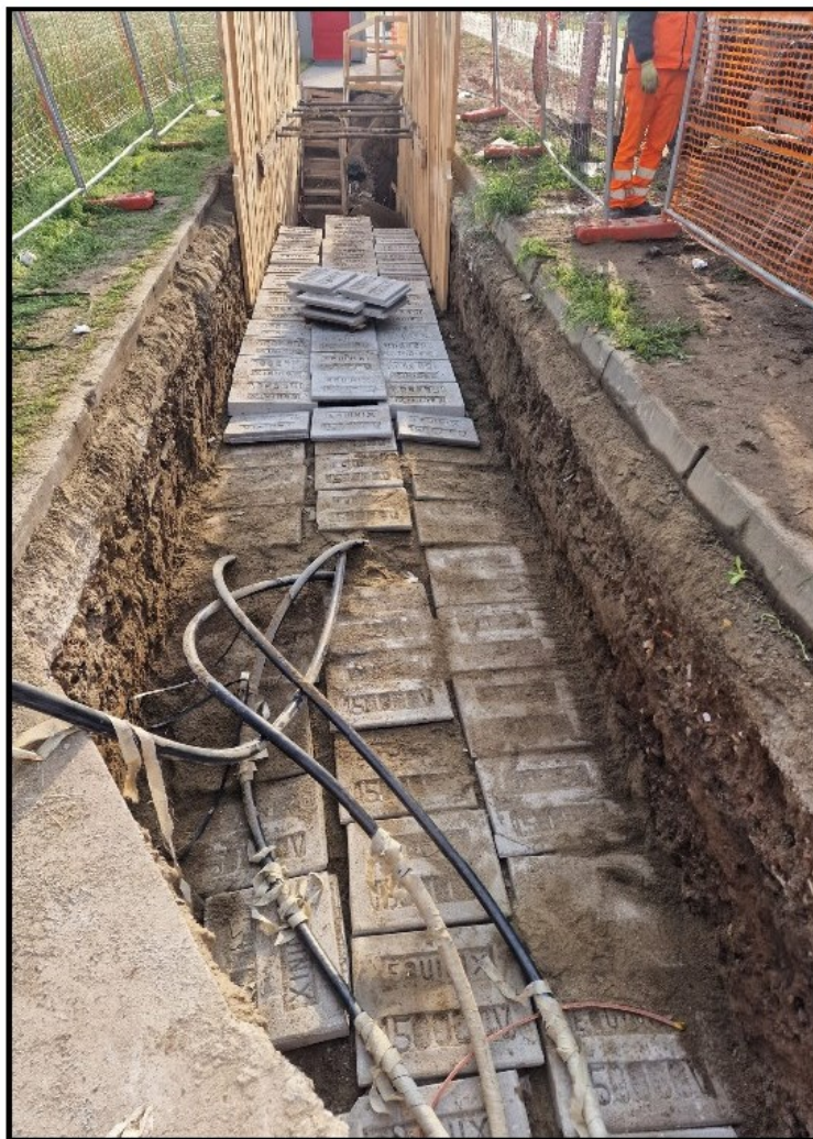
Figura 3.27: Realizzazione elettrodotta interrato. Fase di predisposizione buca giunti cavi AT – posa elementi cls di sicurezza (immagine d’archivio)
