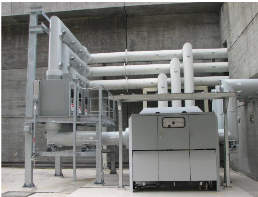
Figura 3.11: Esempio di installazione Sistema IPB (Isolated Phase Bus)
