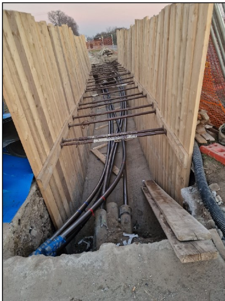
Figura 5.18: Realizzazione elettrodotto interrato. Fase di predisposizione buca giunti cavi AT (immagine d'archivio)
