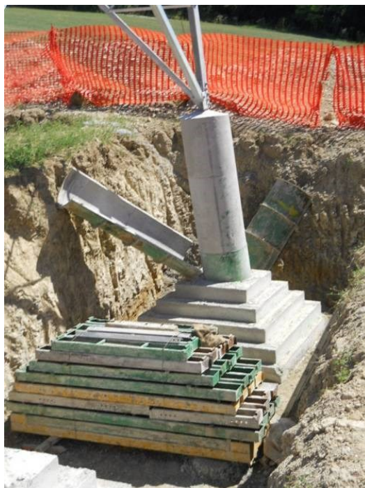
Figura 5.14: Realizzazione di fondazioni superficiali tipo CR per un sostegno a traliccio. Nell'immagine si può osservare una fondazione CR appena "scasserata". Si possono distinguere facilmente la parte inferiore a parallelepipedi tronco piramidali ed il colonnino di raccordo con la "base" del sostegno (immagine d'archivio)
