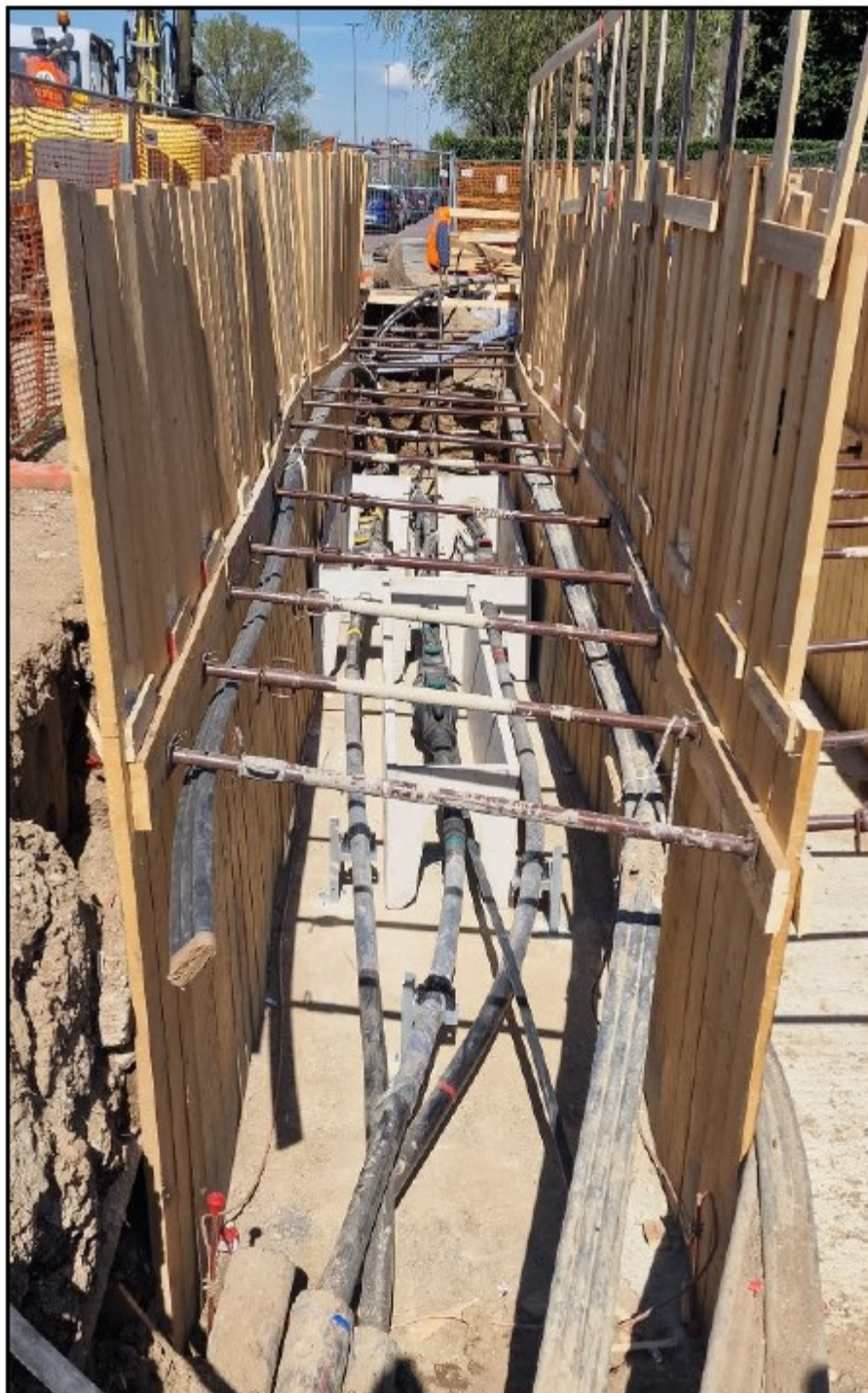
Figura 5.19: Realizzazione elettrodotto interrato. Fase di predisposizione buca giunti cavi AT – giunti (immagine d'archivio)
