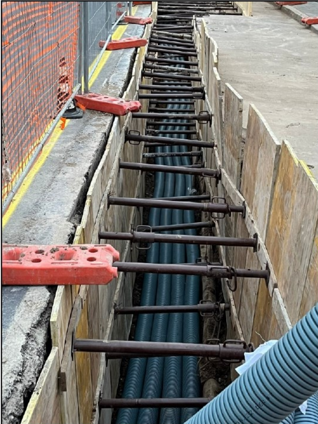
Figura 5.16: Realizzazione elettrodotto interrato. Fase di scavo predisposizione tubiere di alloggiamento cavi AT (immagine d'archivio)
