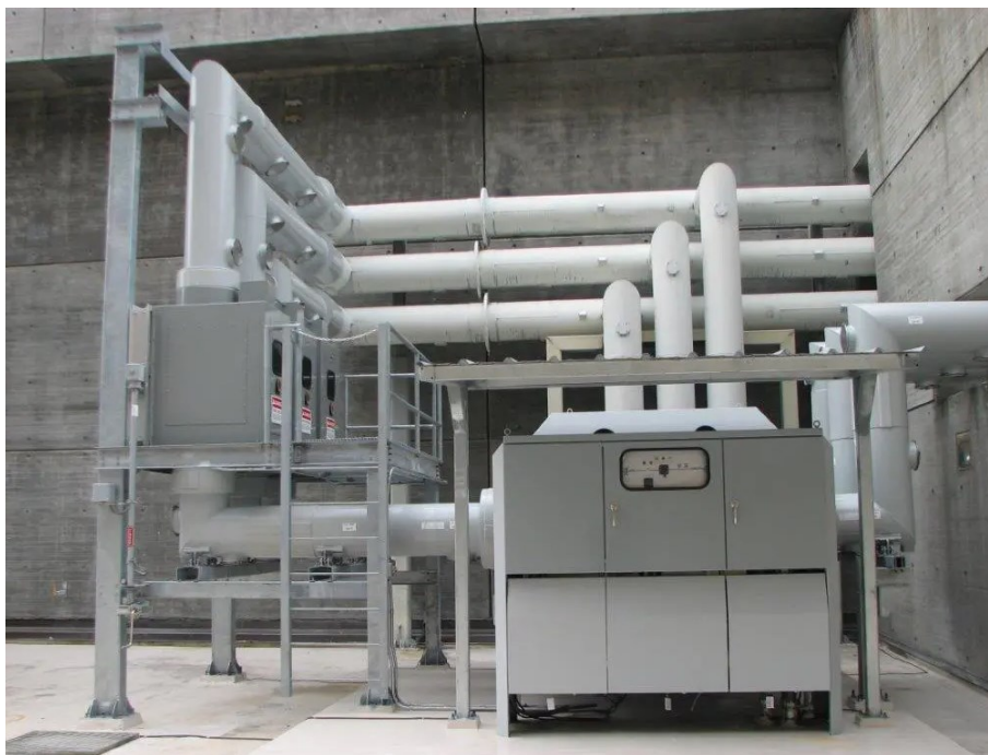
Figura 5.4: Esempio di installazione Sistema IPB (Isolated Phase Bus)
