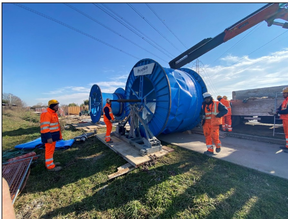
Figura 5.17: Realizzazione elettrodotto interrato. Fase di posa cavo AT (immagine d'archivio)
