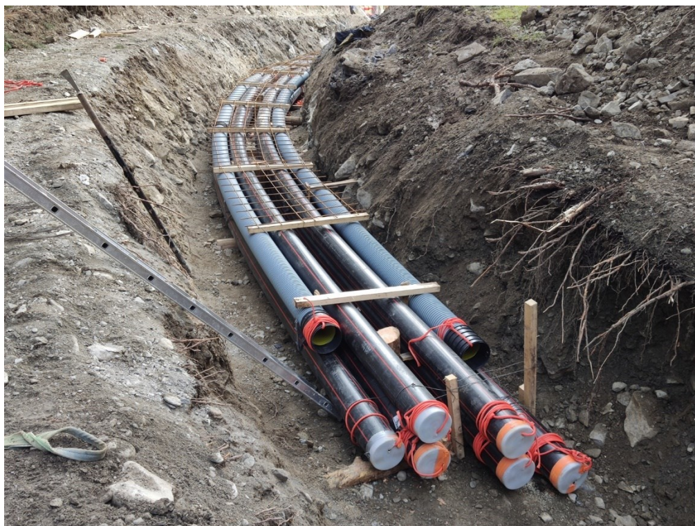
Figura 5.1: Esempio di posa in trincea
