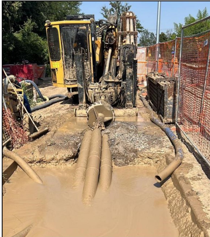
Figura 5.15: Realizzazione elettrodotto interrato. Fase di scavo mediante trivellazione orizzontale controllata (immagine d'archivio)
