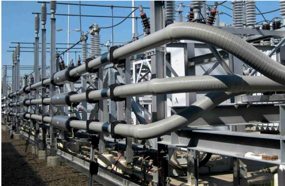
**Figura 3.6:** Esempio di installazione Sistema IPB (Isolated Phase Bus) – fonte: Duresca ® Bus bar system (Moser Glaser)
