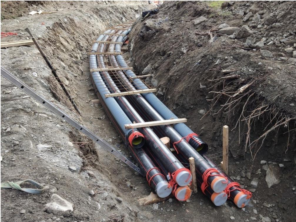
Figura 3.4: Esempio di posa in trincea
