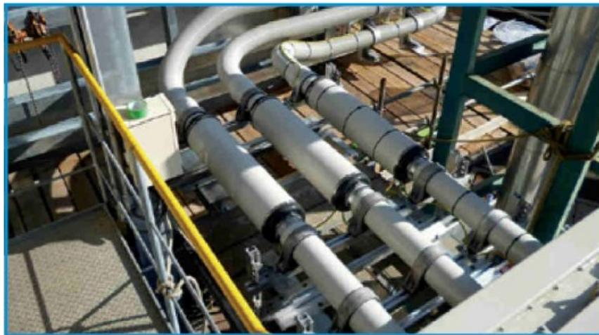
Figura 3.5: Esempio di installazione Sistema IPB (Isolated Phase Bus) – fonte: Duresca © Bus bar system (Moser Glaser)
