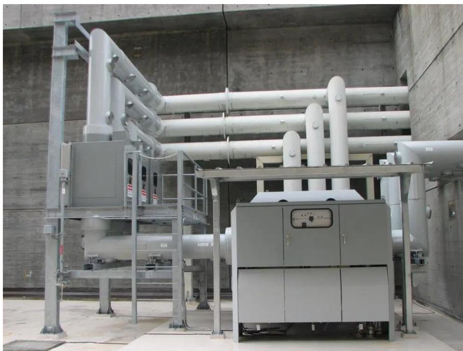
**Figura 3.7:** Esempio di installazione Sistema IPB (Isolated Phase Bus)
