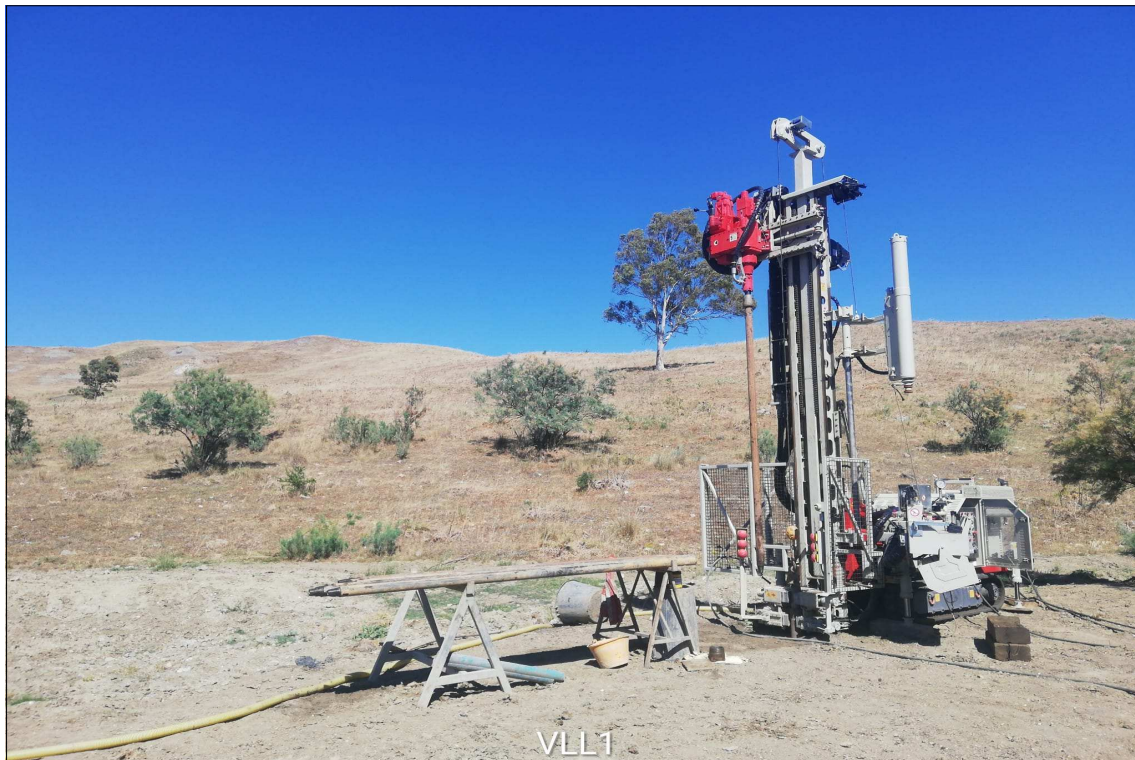
Postazione di sondaggio
