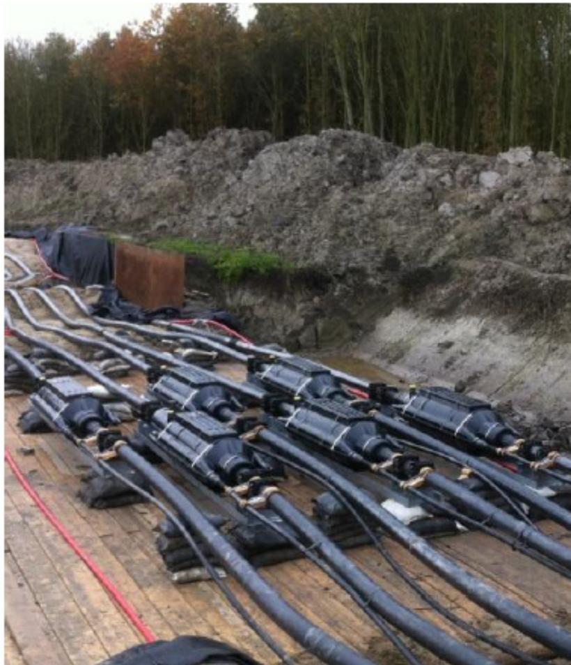
**Abb./Fig. 2: Verbindungsmuffe mit Schirmtrennstelle und Schirmanschlusskabel (exemplarisch) / Straight Joint with Sheath Sectionalising Insulation and Bonding Leads (exemplary)**
