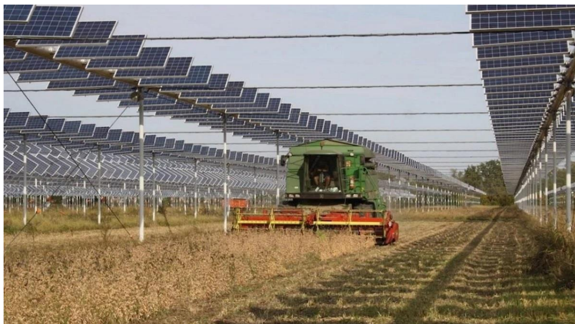
Figura 9 – Esempio di impianto che permette la raccolta meccanica dei cereali (internet)
