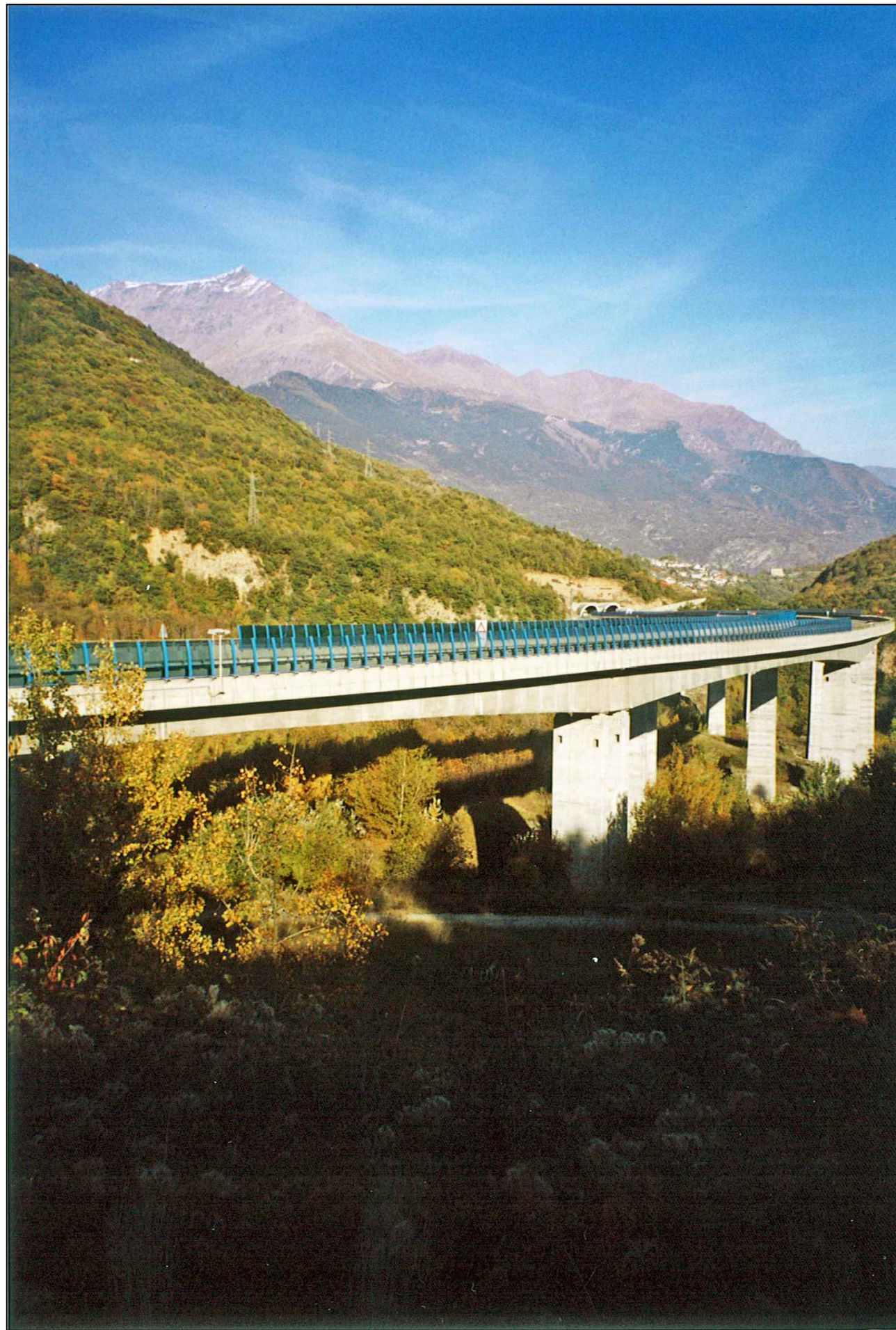
Photo 1: Vue du viaduct Clarea de la voie de l'Avanà / Foto 1: Vista del Viadotto Clarea da Via Dell'Avanà
