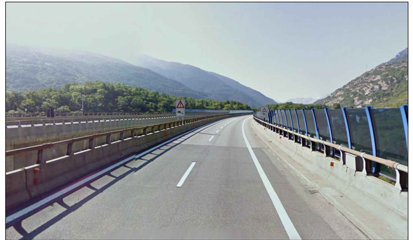
Photo 2: Vue des viaduc autoroutier existant, direction Bardonnèche ( source: Street View ) / Foto 2: Vista dal viadotto autostradale esistente, direzione Bardonecchia (fonte: Street View)
