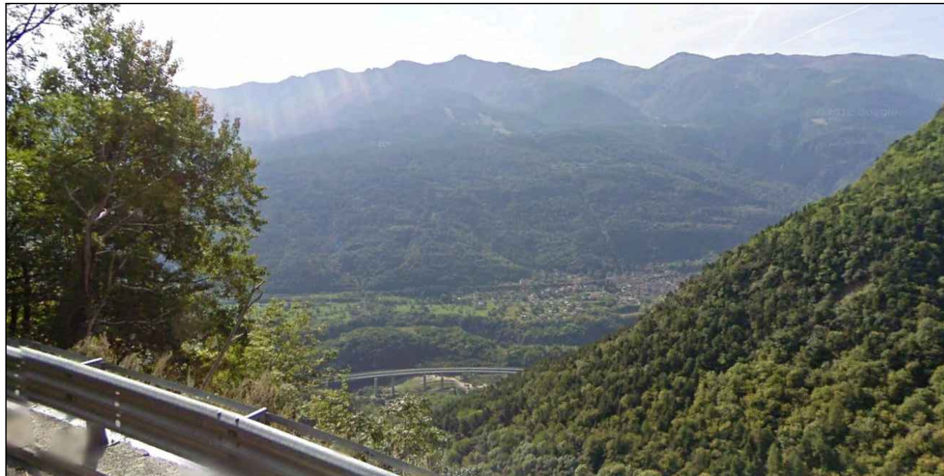
Photo 5: Vue du Viaduct Clarea du SP 255 du Val Clarea / Foto 5: Vista del Viadotto Clarea dalla SP 255 della Val Clarea
