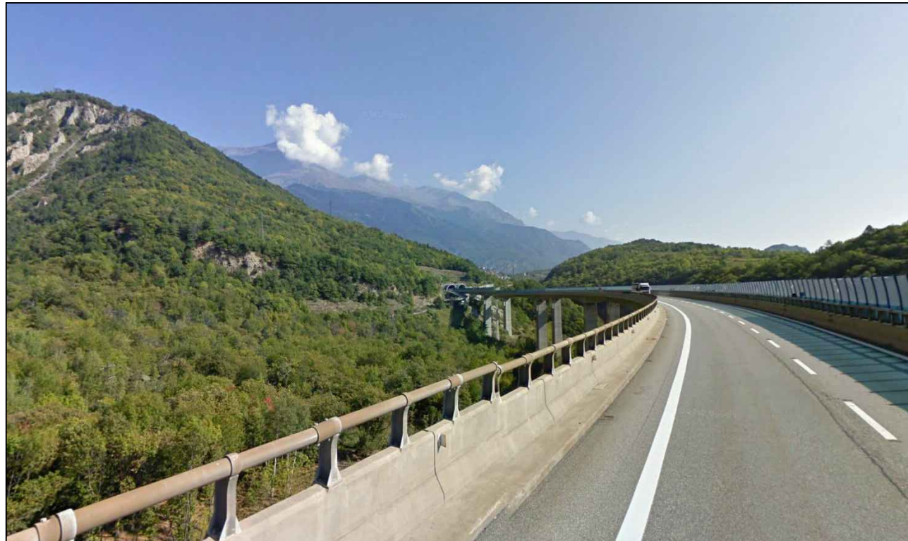
Photo 3: Vue des viaduc autoroutier existant, direction Turin ( source: Street View ) / Foto 3: Vista dal viadotto autostradale esistente, direzione Torino (fonte: Street View)
