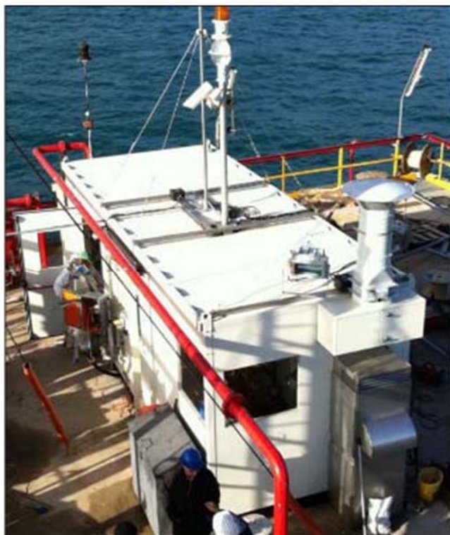
Figura 12 - Esempio Control room Terminale
