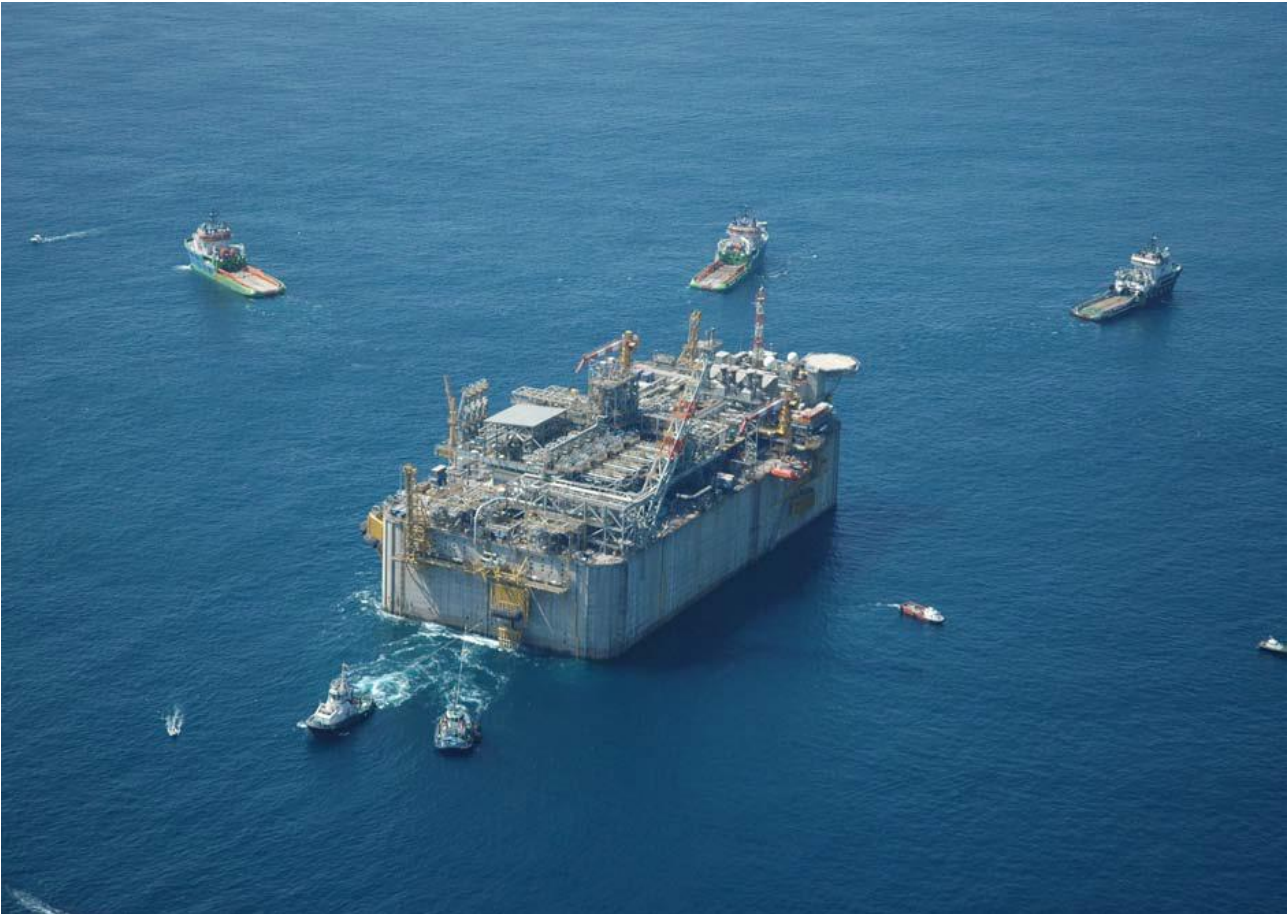
Foto 5 - Rigassificatore offshore progettato da Aker Kværner
