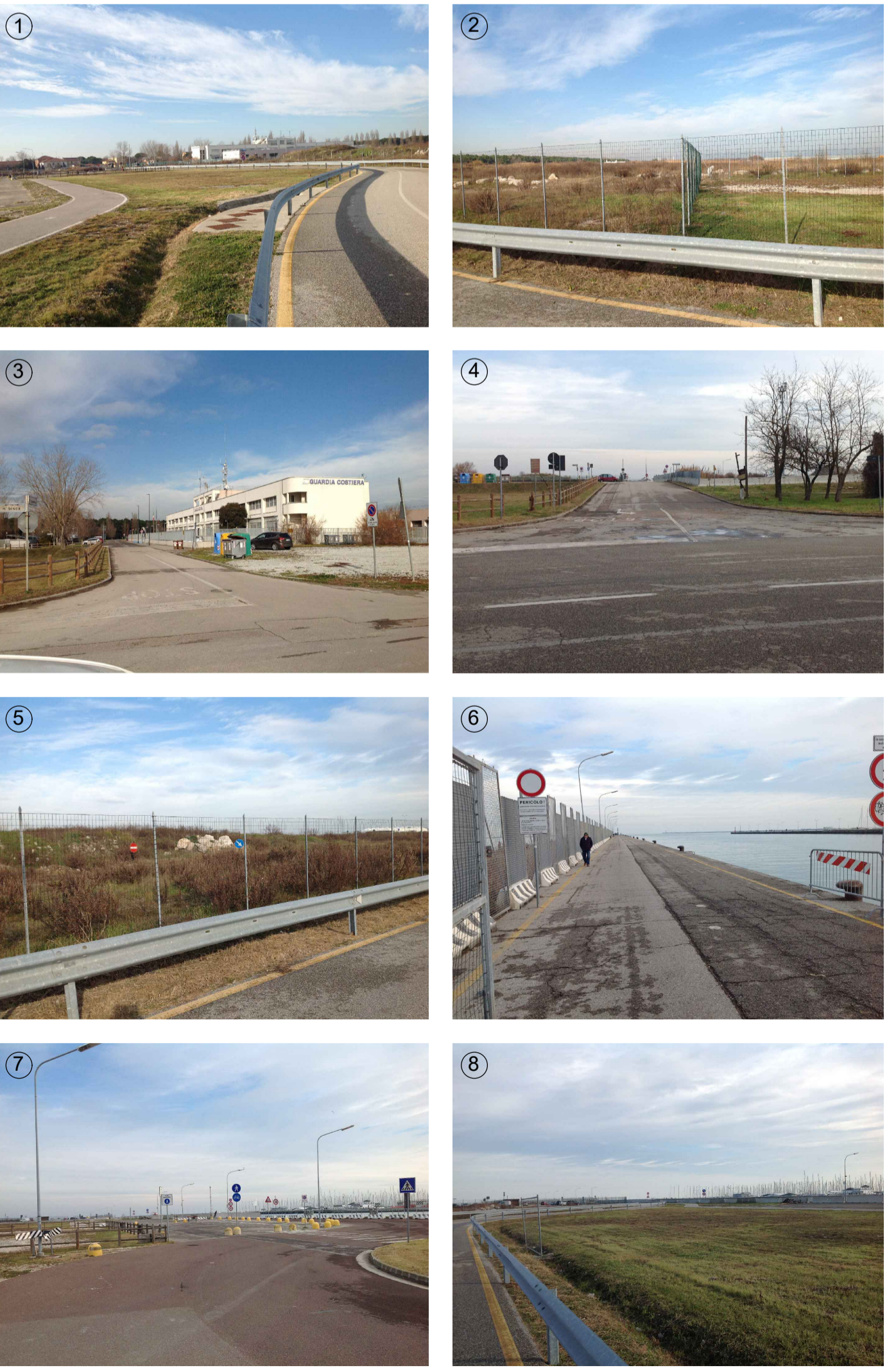
Foto stato di fatto
