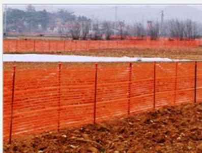
**Figura 5.4: Recinzione da utilizzare per separare singole attività lavorative all'interno dell'Area di Lavoro o aree di stoccaggio rifiuti**
