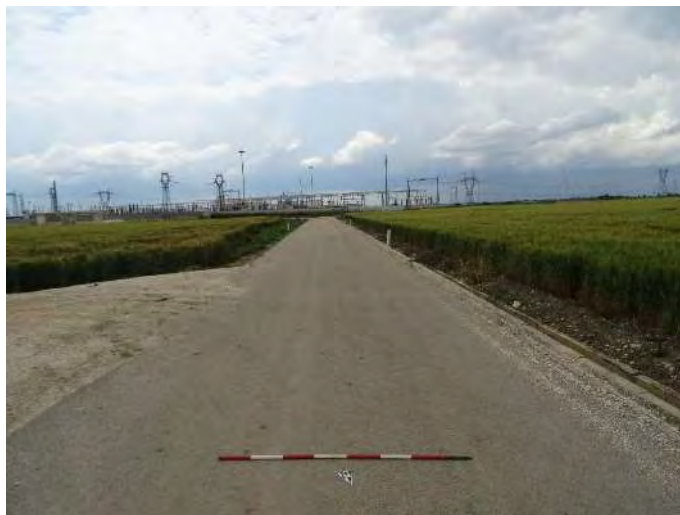
Figura 44: UR 6, SE di Macchia Rotonda, vista da N.
