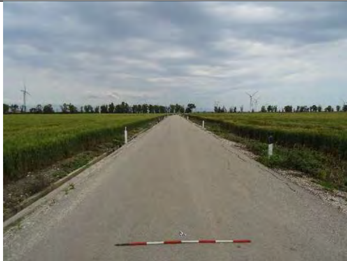
Figura 43: UR 6, strada di accesso alla SE di Macchia Rotonda, vista da S.
