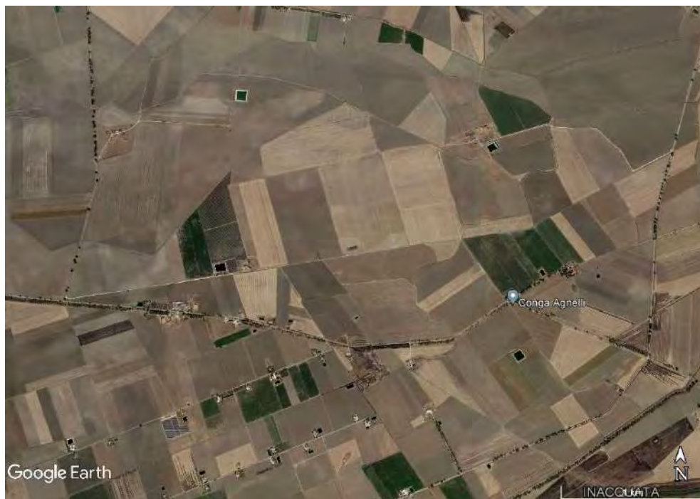
Figura 22: Ortofoto dell'area interessata dall'elettrodotto interrato che si sovrappone alla SP 70 (fonte immagine : Google Earth 08/2017).
