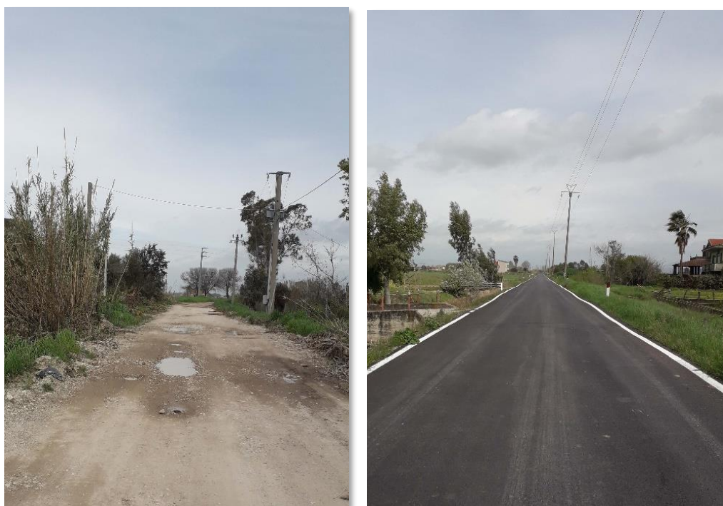
Figg. 7-8 Un tratto della strada sterrata interpodereale di accesso al campo agri fotovoltaico e di via Armando Diaz, che conduce all'area destinata a SE e SU.
