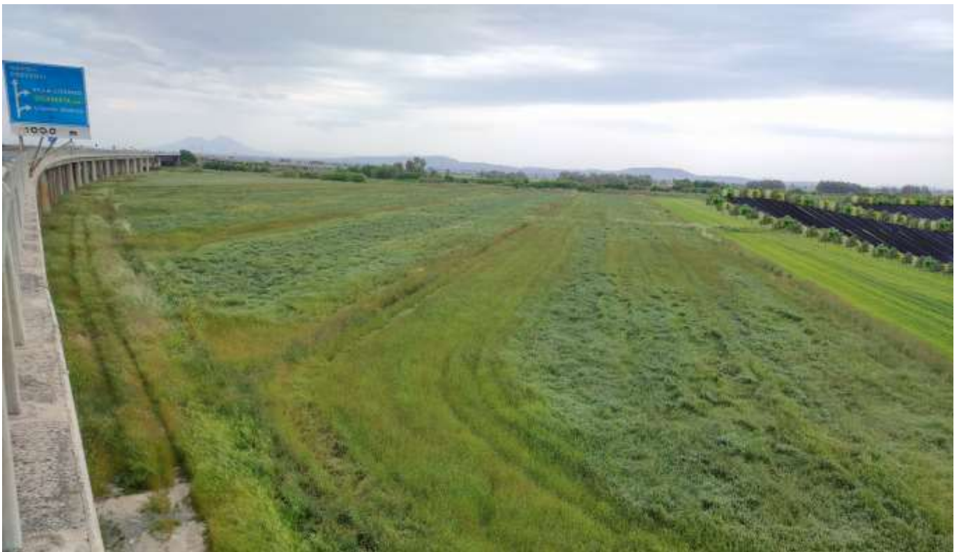
Tracker FOTO B – stato POST operam
