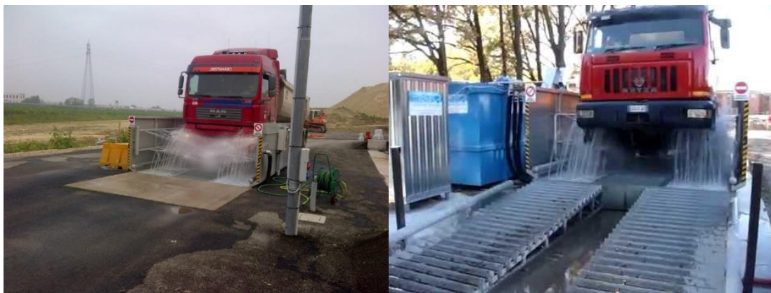
Figura 12-2 Esempio di impianto di lavaggio ruote
