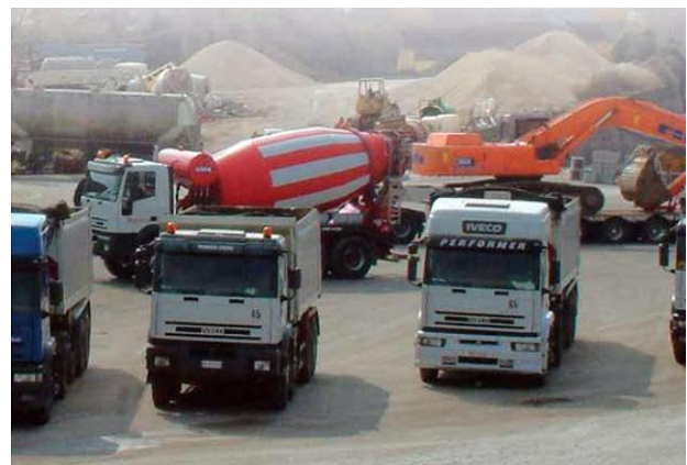
Area per il deposito dei mezzi di cantiere
