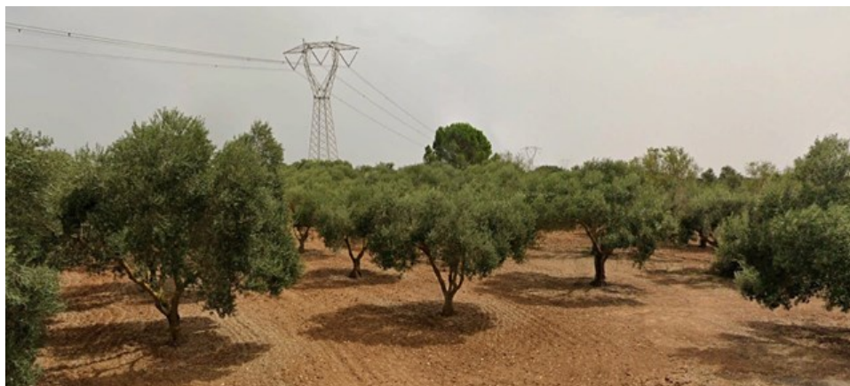
Figura 1.10: Linea AAT Terna – Campagna Sarda di Serrenti
