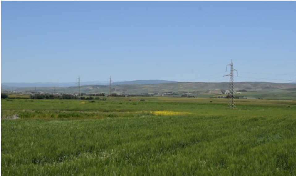
Figura 1.12: AAT Terna – Campagne di Sanluri - Sardegna
