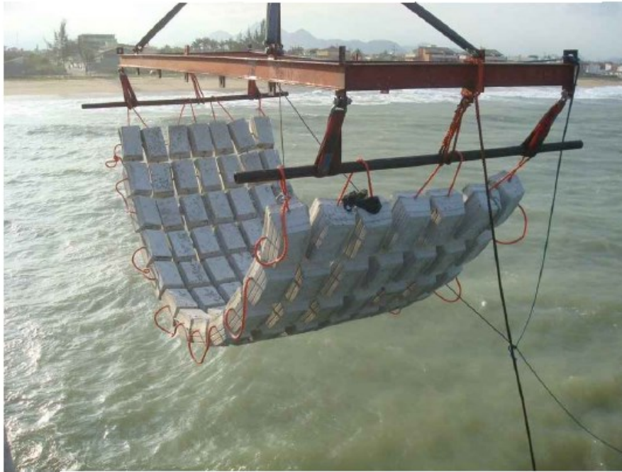
Figura 4.7: Tipologico di materassino per la protezione del cavo subacqueo
