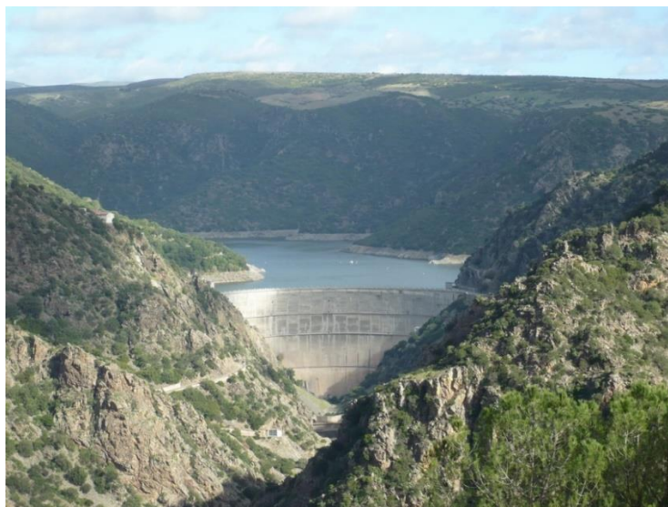
Figura 4.3: Diga di Nuraghe Arrubiu vista da Valle (Fonte: http://www.enas.sardegna.it/il-sistema-idrico-multisettoriale/laghi-artificiali/nuraghe-arrubiu.html )
