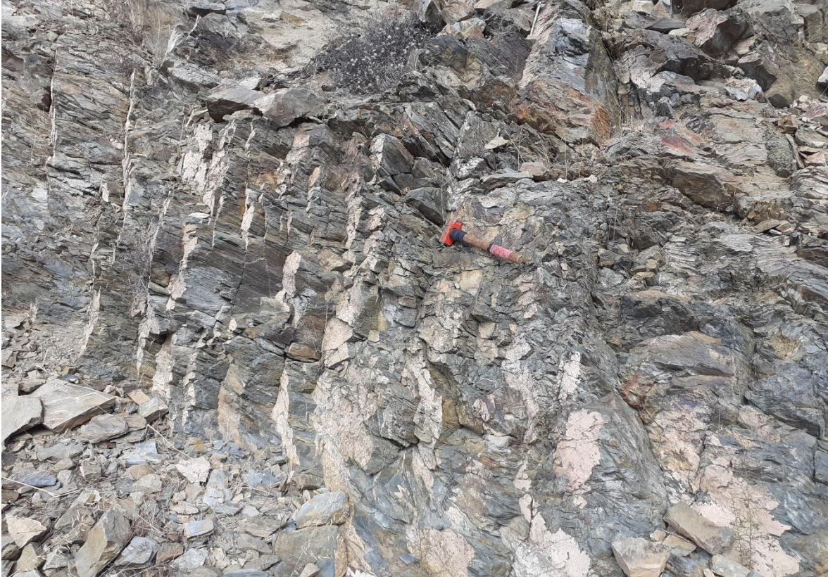
Figura 4.12 – Ripresa dell'affioramento roccioso dove è stata rilevata la stazione geo-strutturale GNA-01
