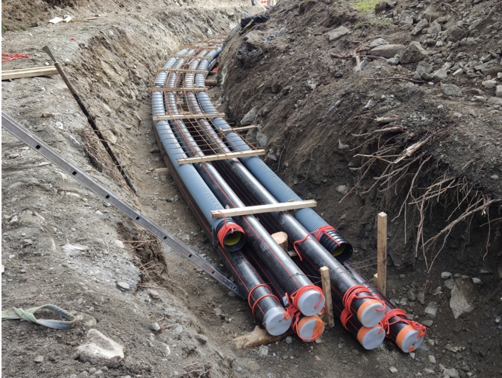
Esempio di posa in trincea
