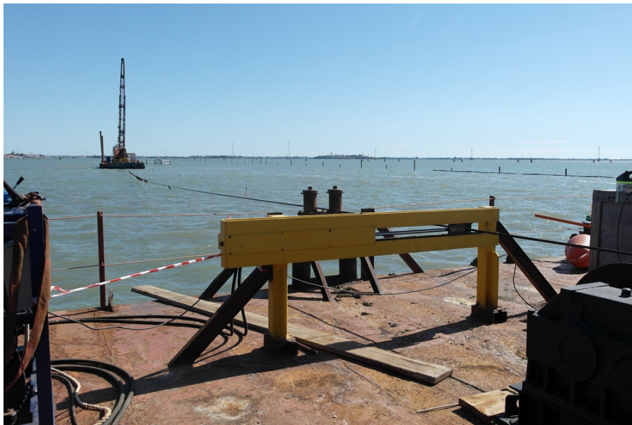
Vista del cavo di tiro per avanzamento del pontone di posa
