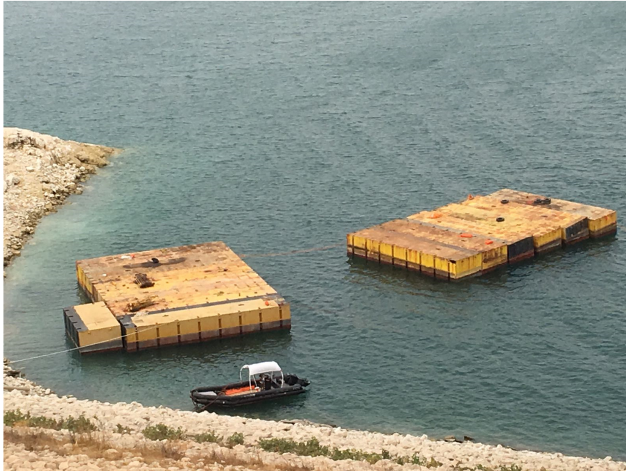
Assemblaggio dei moduli galleggianti
