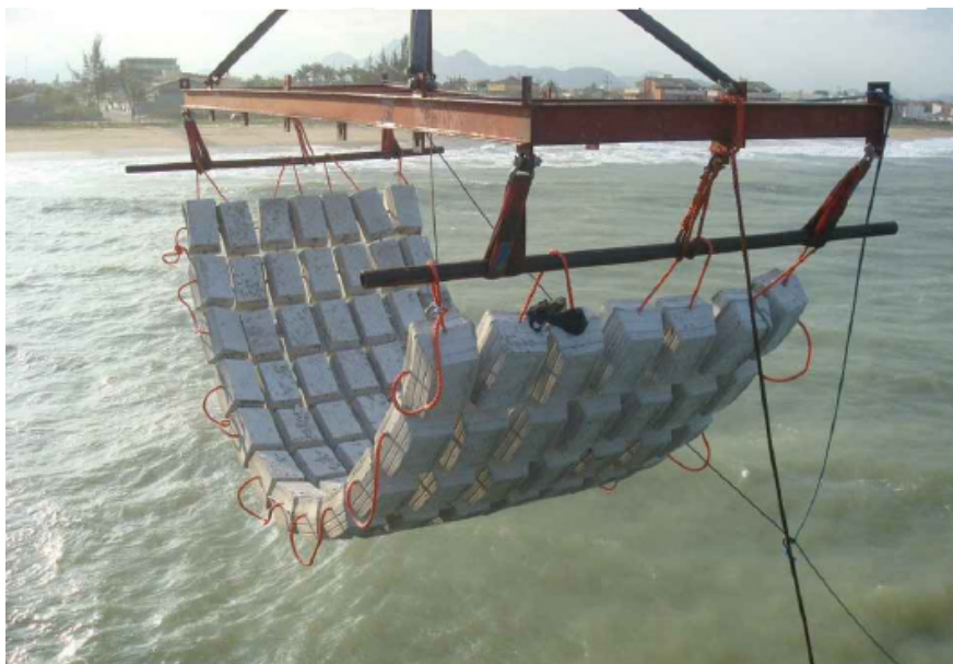
Tipologico di materassino per la protezione del cavo subacqueo
