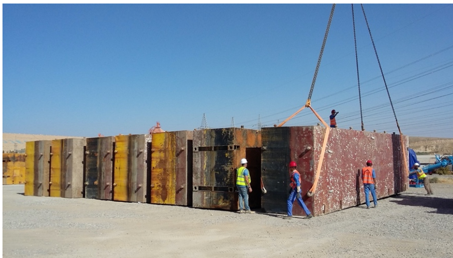
Movimentazione dei moduli galleggianti
